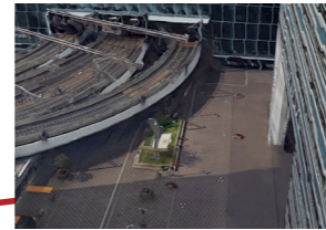
2. Tram track above Anna van Buerenplein
