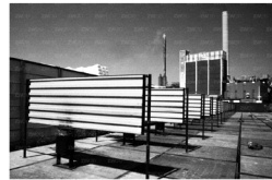
Afwerkplaats, Keileweg By zwartwit010
