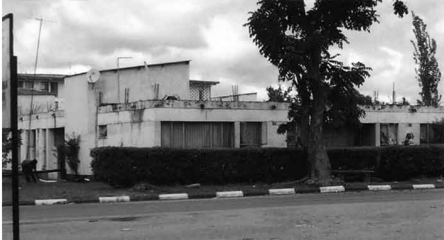
An incomplete block of flats at Kafue Estates.
