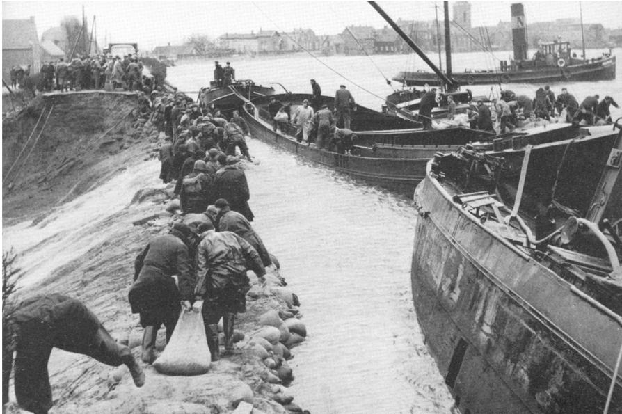
Figure 17-4 Closure dike breach Ouderkerk aan den IJssel 1953.
