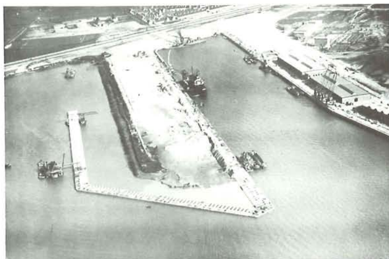
Luchtfoto van de in aanbouw zijnde kademuur Merwehaven
