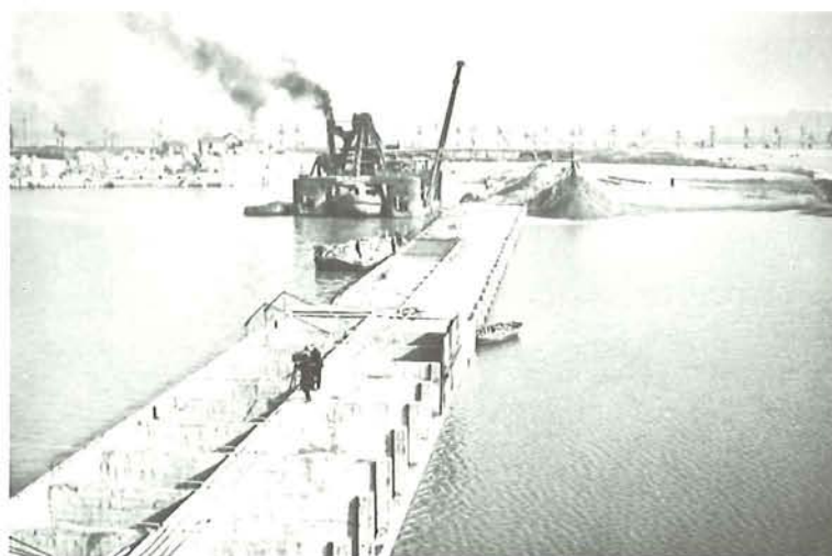
De installatie voor de bouw, gesitueerd in de Waalhaven
