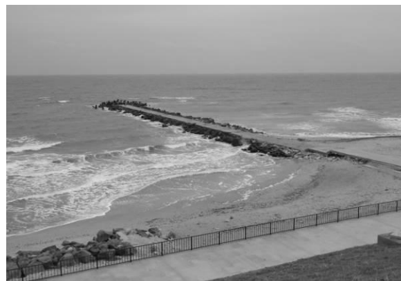
Fig. 3.59 South Eforie groin (Romania)
