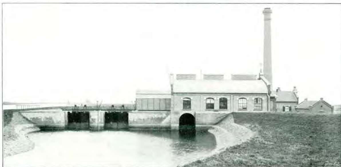
Fig. 48. Afsluitings- en bemalingswerken aan den benedenmond van het zuiderafwateringskanaal. Buitenaanzicht.
