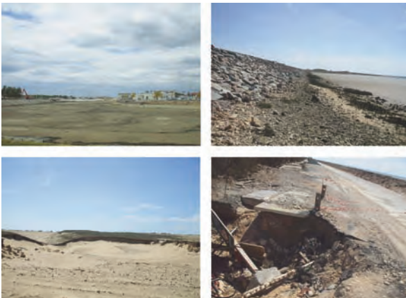
Figuur 16: L'Aiguillon-sur-Mer, met de klok mee: herstel in de haven, noodherstel van een doorgebroken betonnen waterkering, gemeentelijke infrastructuur vernietigd en duinerosie.
