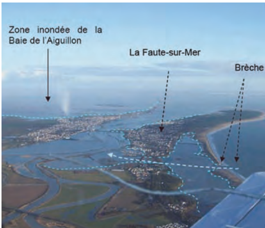
Figuur 13: Luchtfoto van het dorp La Faute-sur-Mer, georiënteerd richting het zuiden. De foto toont een grote bres in de duin ten noorden van het dorp. De pijl geeft schematisch aan waar de waterkeringen gefaald hebben. [20].
