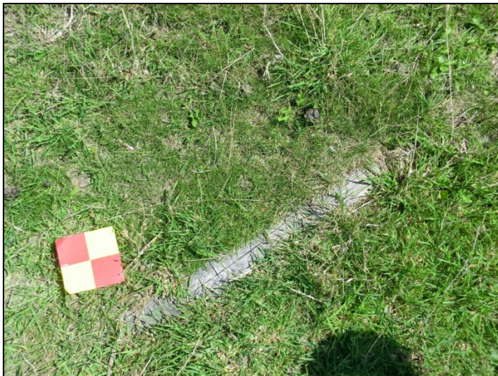
Foto 15. Proefvak 18: paal in dijktaalud.
