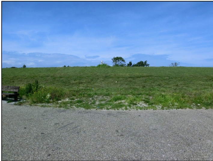
Foto 43. Proefvak 42: Voorland en onderkant van dijktalud zijn erg kaal.
