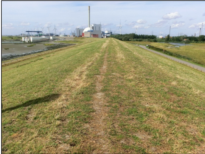
Foto 65. Proefvak 60: dijkvak beweid met schapen, ziet er netjes uit, maar zode vrij open. Wel schapenpad boven op de dijk.
