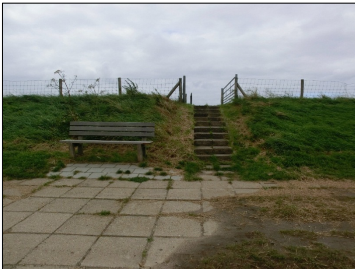
Foto 80. Proefvak 75 - 76: trap in dijktaalud. Naast de trap is gemaaid, maar het maaisel is blijven liggen.
