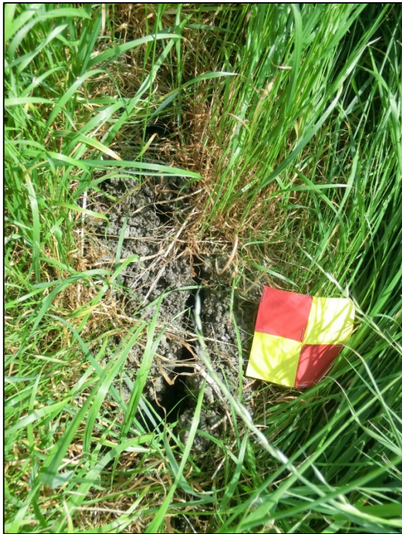
Foto 55. Proefvak 52: droogte scheur.
