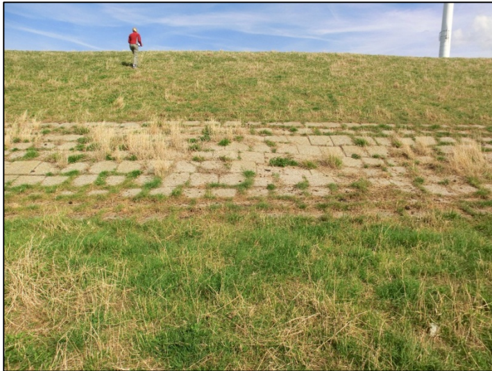
Foto 64. Proefvak 59: onderste deel dijktalud met tegels bekleed.
