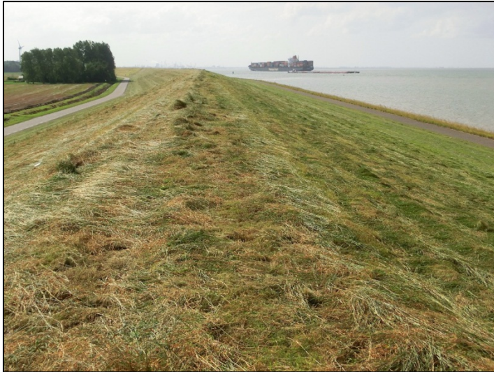
Foto 100. Proefvak 94: pas gemaaid dijktalud met mooie dijk glooiing.
