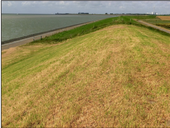
Foto 57. Proefvak 53: maaisel is net geraapt van het dijkvak.
