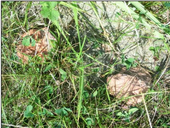
Foto 49. Proefvak 46: stenen in dijktalud.
