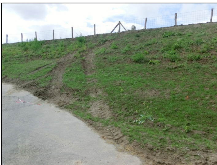
Foto 87. Proefvak 81: recent opgeleverd dijktaalud met rijspoor
