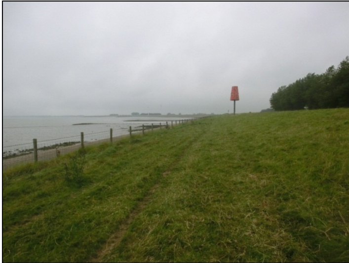
Foto 2. Proefvak 2 en 3: geleidelijke overgang van dijkwalud naar onderberm, met schapenpad.
