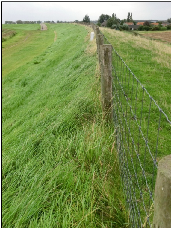
Foto 78. Proefvak 75: boven op dijk staat een raster.
