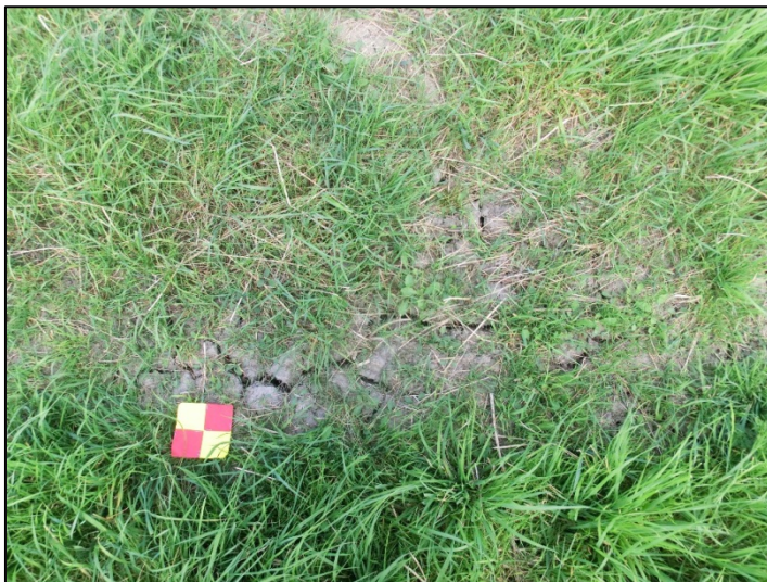
Foto 61. Proefvak 56: droogte scheuren.
