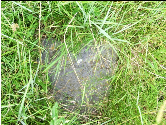
Foto 33. Proefvak 34: basaltblok in het dijktalud.
