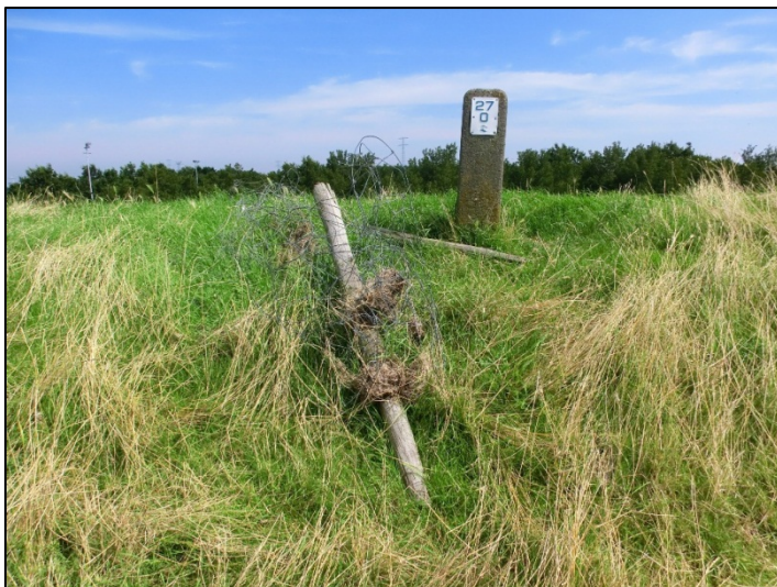
Foto 26. Proefvak 28: dijkpaal met extra paal en gaas.
