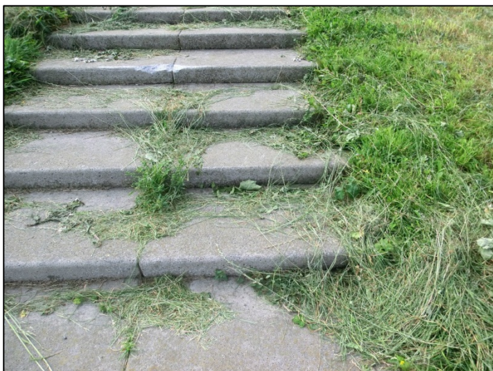
Foto 105. Proefvak 100: trap in het dijktalud.
