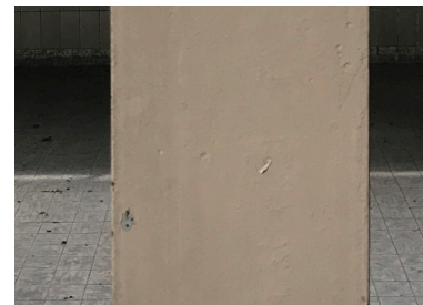
Fig: Steel column
