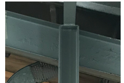
Fig: Steel beam
