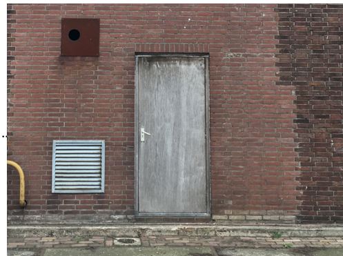
Fig: Steel door
