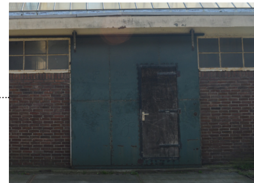
Fig: Steel door
