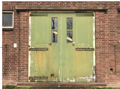
Fig: Steel door
