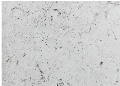
Fig: Concrete wall
