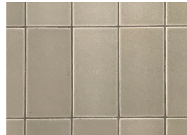
Fig: Brick wall
