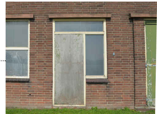
Fig: Steel door
