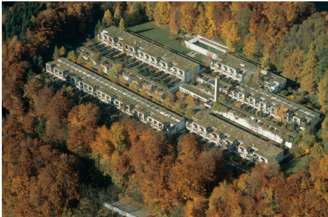
Siedlung Halen, Atelier 5, Switzerland
