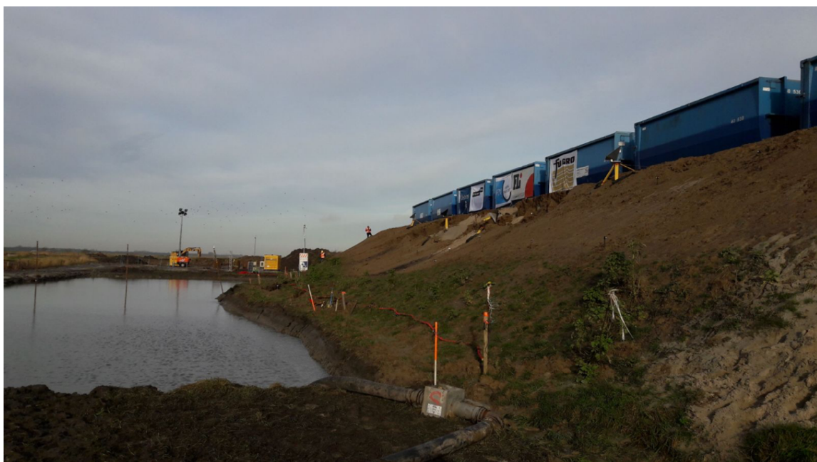
Figuur 9 Foto van het bezwijken van de groene dijk.
