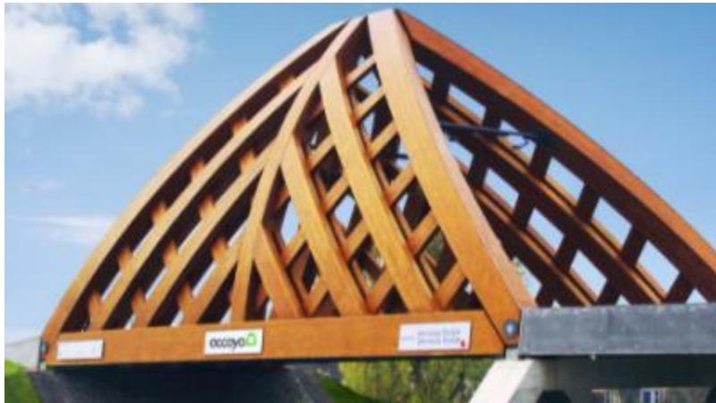
Figure 6.5: Accoya Bridge, close to Sneek, from [ https://www.shr.nl/case-studies/houten-brug-bij-sneek-voor-de-zwaarste-verkeersklasse ]
