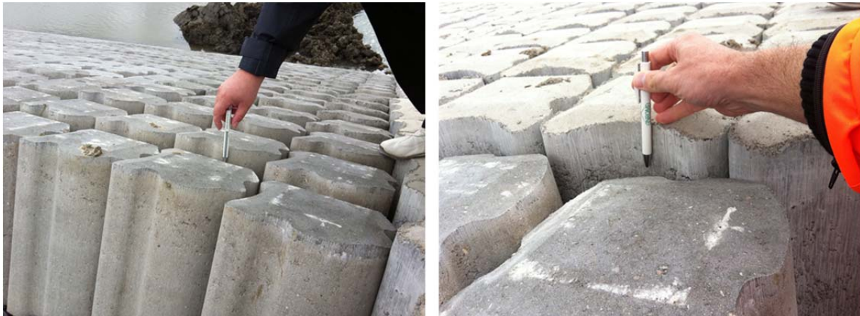
Abbildung 8.34: Verlegungsgenauigkeit des Hydroblocks an der Westerschelde (Niederlande), Aufnahme datum 29.08.2011 (Quelle SCHÜTTRUMPF)
