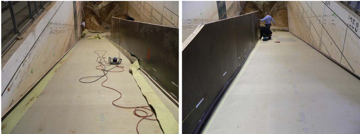
Abbildung 2.10: links: Einbau des Geotextils; rechts: verlegtes Geotextil in Abschnitt 2
