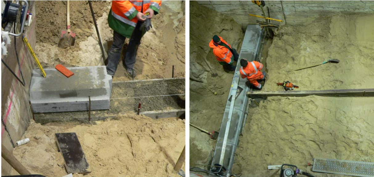
Abbildung 2.5: Fundamentstreifen aus Beton dient der Auflagefläche für den Verkalit®-Holm (BERDING BETON, 2010)
