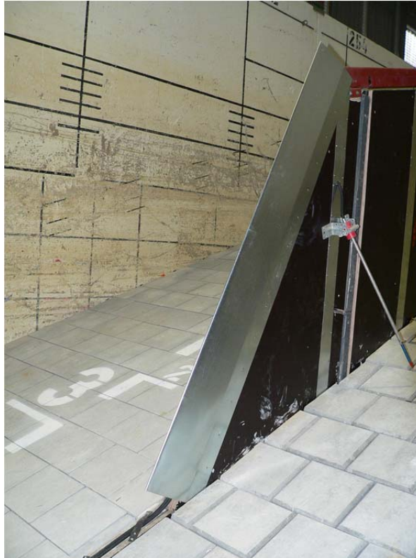
Abbildung 2.9: fertiggestellte Trennwand mit Metallnase
