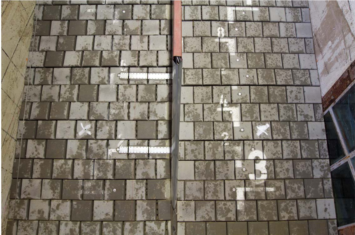
Abbildung 8.22: links: Abschnitt 2 (modifizierter Verkalit®-Deckwerkstein 180 mm) mit verändertem Fugenbild im Bereich von 3,7 m; rechts: Abschnitt 1 (Standard Verkalit®-Deckwerkstein 180 mm) mit verändertem Fugenbild im Bereich von 3,7 m
