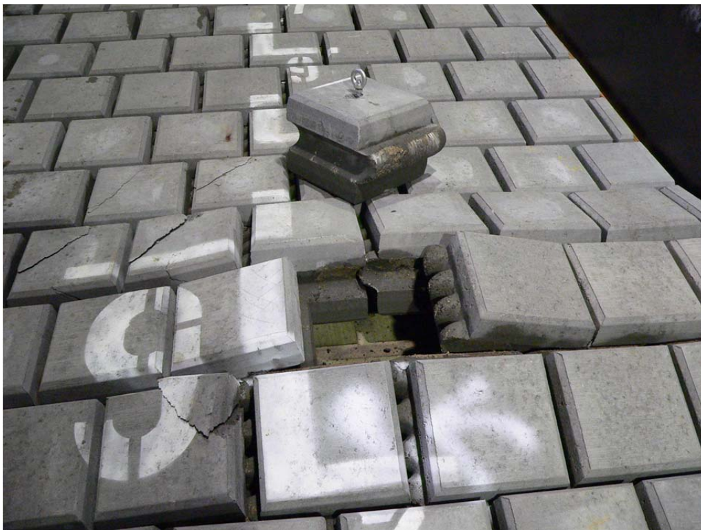
Abbildung 8.55: Erscheinungsbild des ausgezogenen, modifizierten Verkalit®-Deckwerksteins 250 mm 47 E
