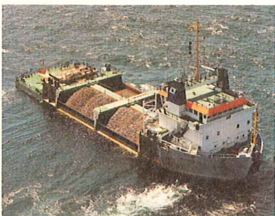
Ter beteugeling van de voortgaande structurele erosie aan strandhoofden of aan de teen van een dijk is het van tijd tot tijd noodzakelijk steen te storten ter versterking van de constructie.
