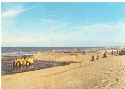
Zandsuppleties vormen de kern van de erosiebestrijding.
