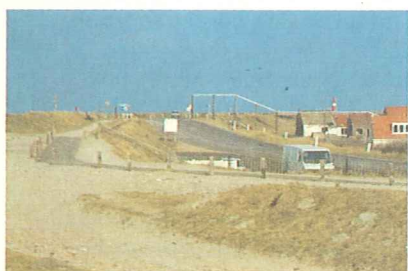
Voor versterking van de zeewering moet blijvend ruimte worden gereserveerd. De benodigde ruimte kan aanzienlijk zijn, zoals hier blijkt uit het profiel van witte latten dat de ruimte aangeeft die op deze plaats nodig was voor de Delta-versterking.
