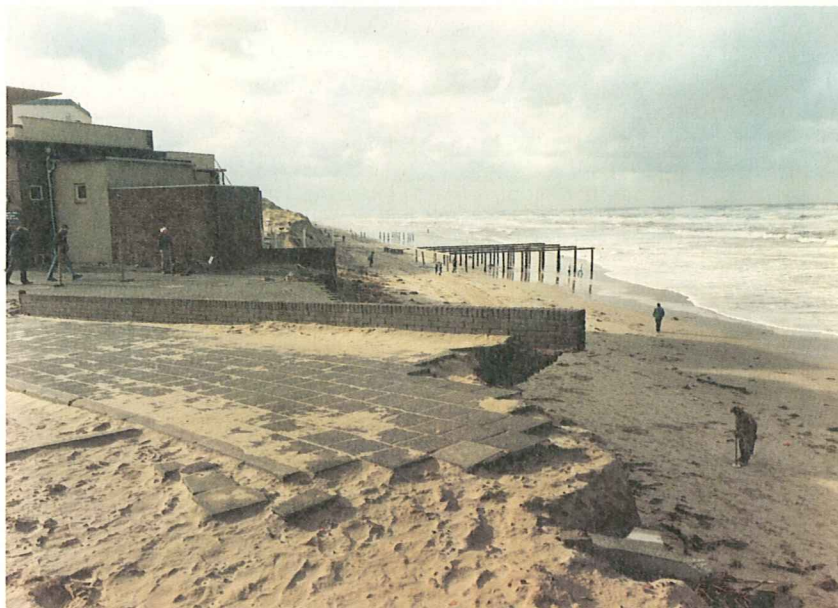
De dreiging van schade aan bebouwing is soms zeer groot. De situatie in Egmond aan Zee is hiervan een goed voorbeeld.
