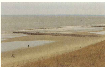
In het verleden zijn veel strandhoofden aangelegd om de kusterosie tegen te gaan. De erosie werd hiermee meestal vertraagd. In sommige gevallen, bijvoorbeeld als getijgeulen dicht langs de kust liggen, kan het in de toekomst wenselijk zijn om strandhoofden aan te leggen.
