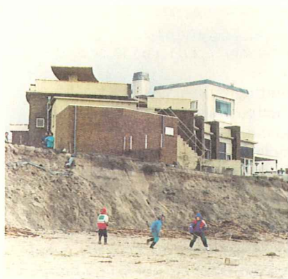
Bij een zware storm kan er een groot deel van het duin afslaan. Objecten op de primaire waterkering kunnen dan schade lijden.
