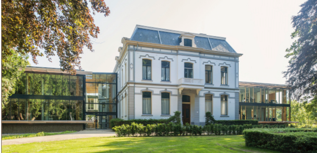
Figuur 26: Gemeentehuis Brummen, gebouw als grondstoffendepot (Van Geffen, 2013)
