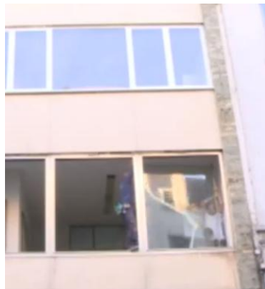
a. Dismantling glazing
