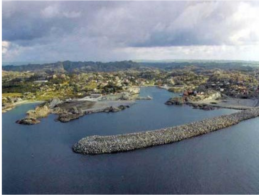
Fig. 2.2 – The Sirevåg berm breakwater (Tørum et al., 2005)
