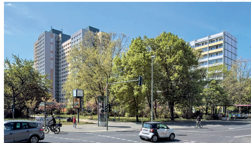
Plattenbau (Karl Marx Allee side)
