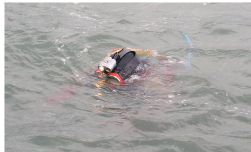
Fig. 2.3 diver checking Xbloc position
