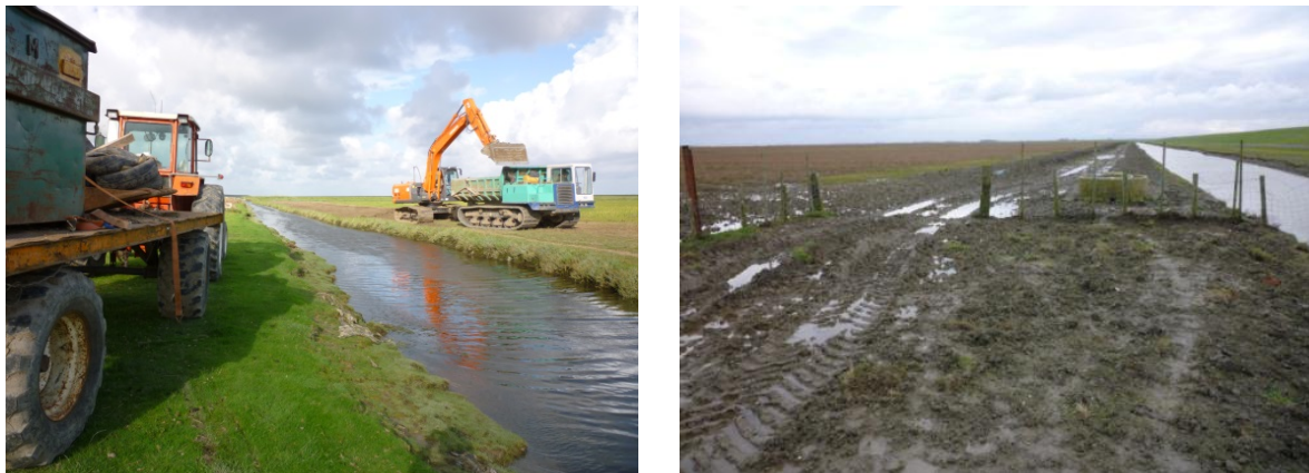
Figuur 7.5 Kwelderherstelproject Groningen (afgraven van de klei langs de sloot om elders op de kwelder hogere vluchtroutes voor het vee te creëren en greppels te verkleinen) (foto's: J.M. van Loon-Steensma).
