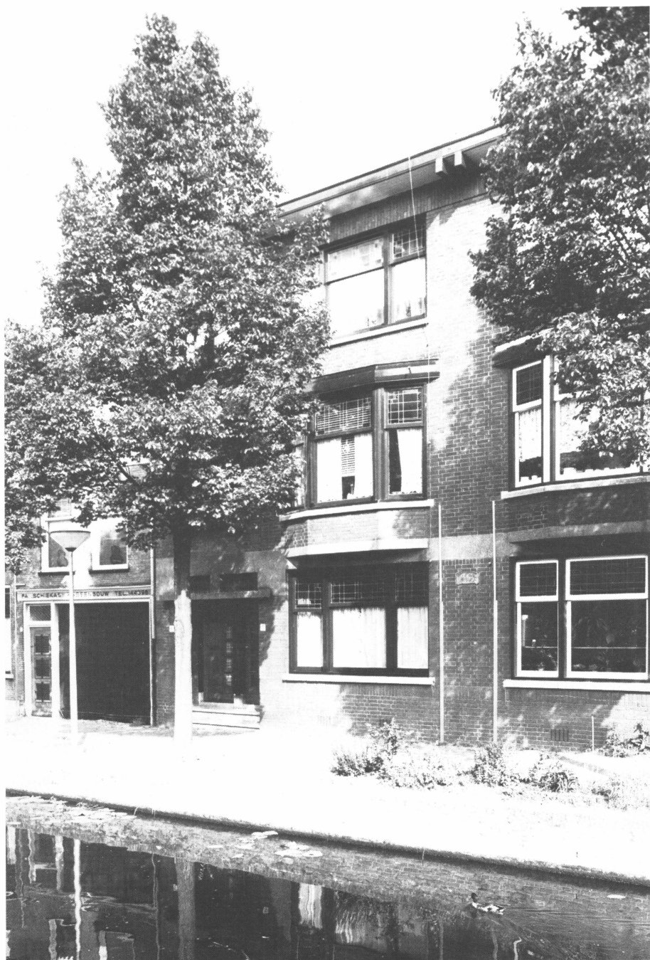
Bedrijf opgenomen in een woning
