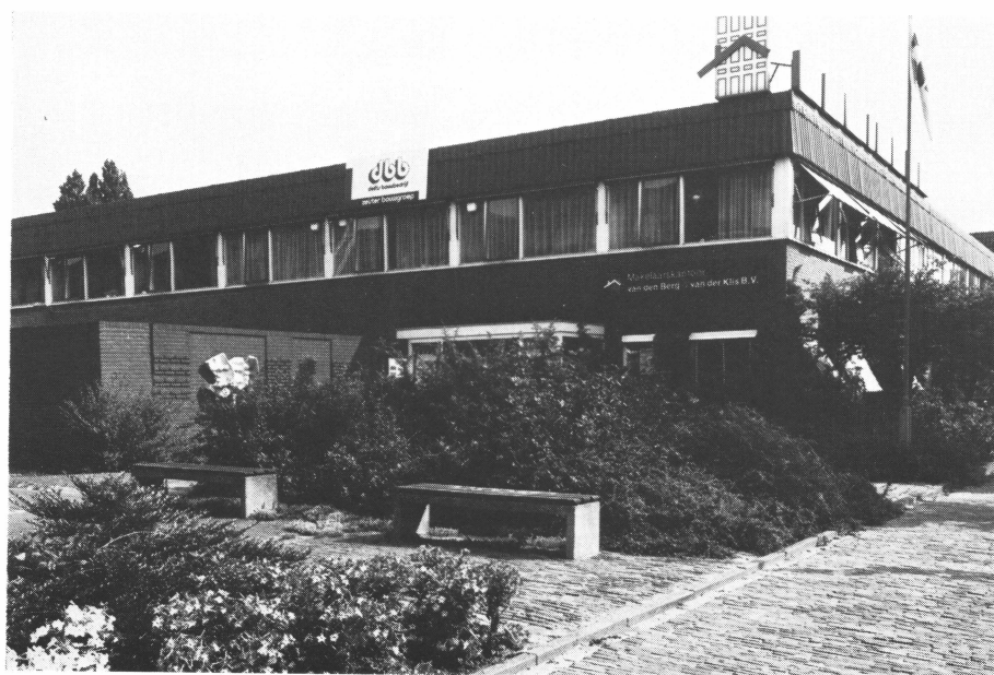
Een nieuw bedrijvencomplex
