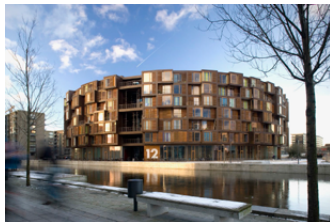
Exterior Tietgen Dormitory (Lindhe, J. M., 2014a)
