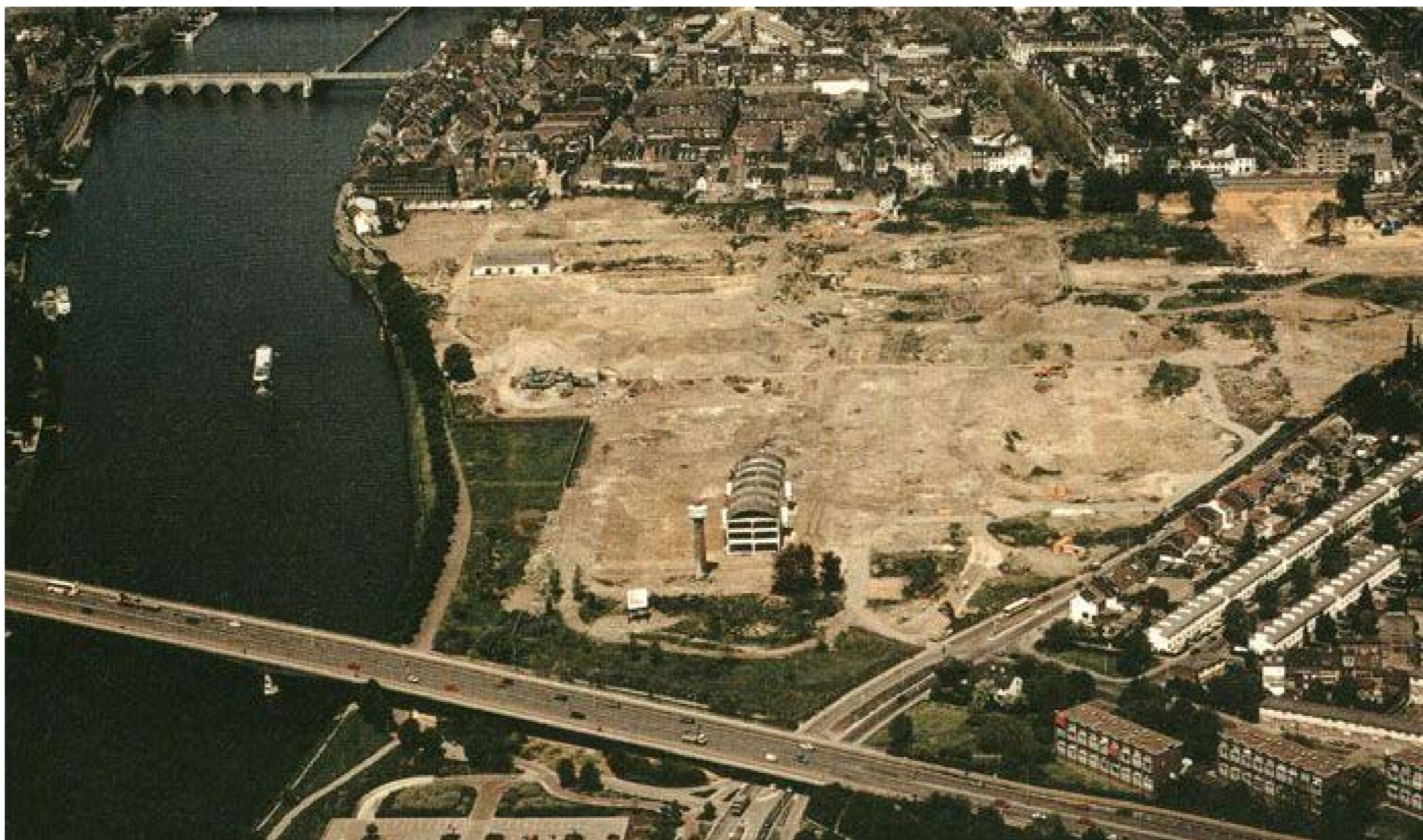
Société Céramique after the demolition phase
