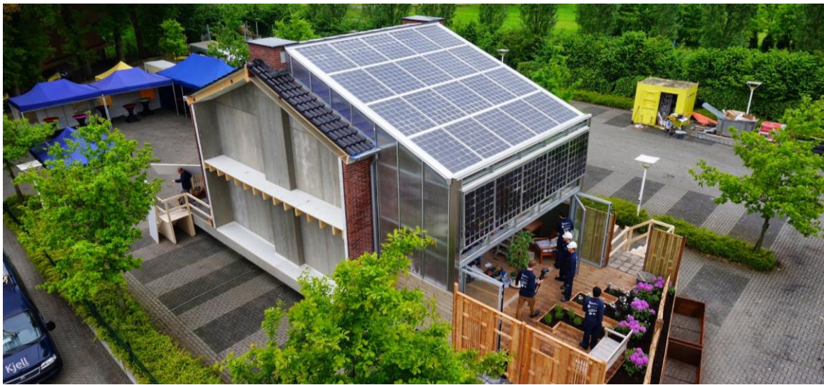
Figure 34: Prêt-à-loger and its remarkable green house (Prêt-à-loger, 2014)
