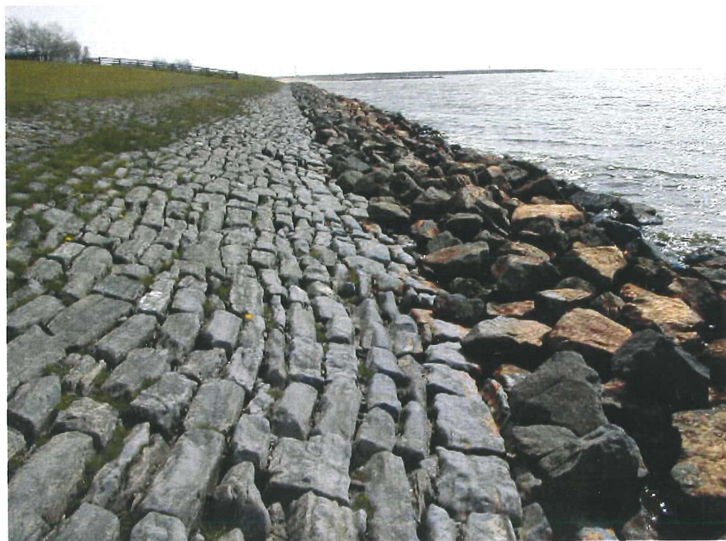
Foto 2. Teenbestorting IJsselmeerdijk bij Stavoren
