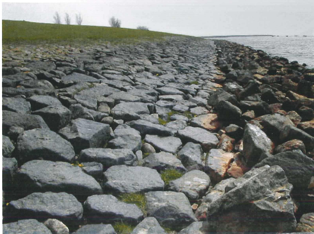
Foto 1. Teenbestorting IJsselmeerdijk bij Stavoren
