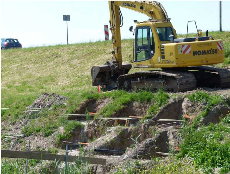
Figuur 23: Aanbrengen kopconstructie
