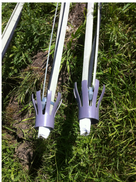
Figuur 20: Fixatie nagelement
