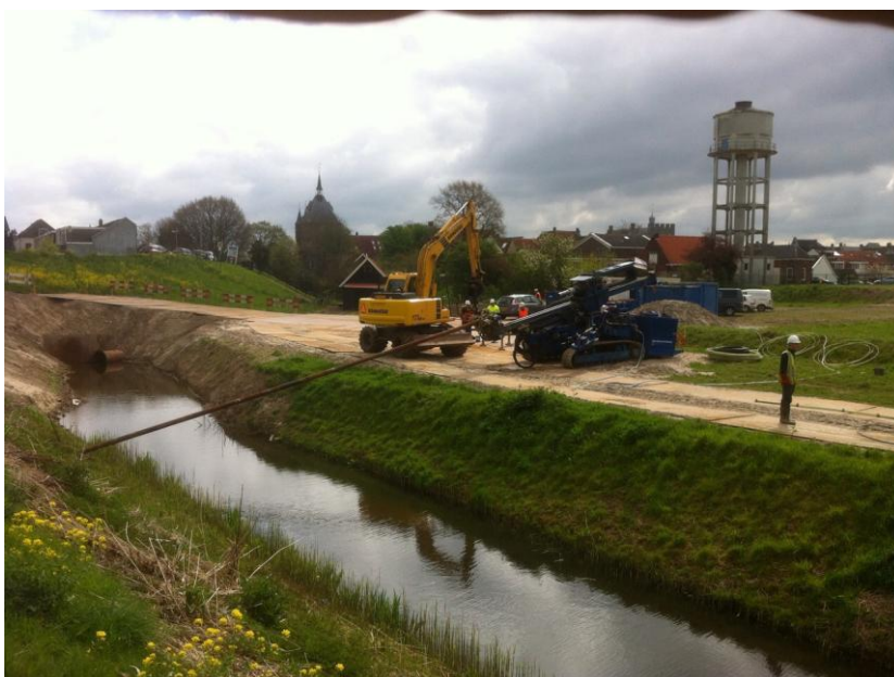
Figuur 1: Inboren van de nagels op de projectlocatie.
