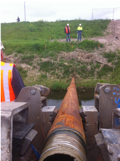
Figuur 19: Aanzicht ingeboorde boorbuis
