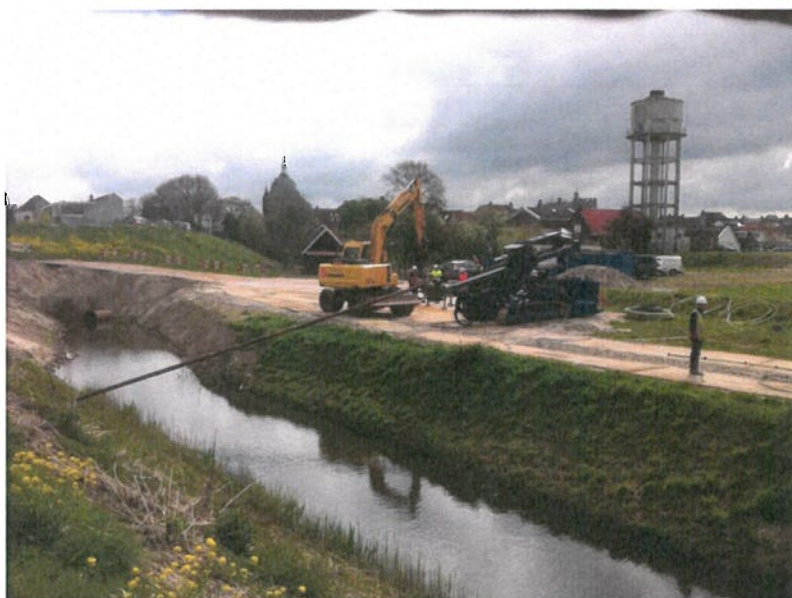
Figuur 1: Inboren van de testnagels op de projectlocatie.
