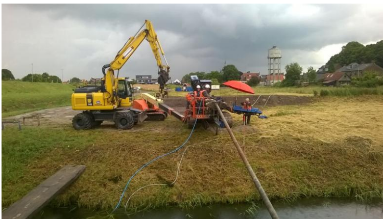
Figuur 14: Foto-impressie van het werkterrein ten behoeve van het aanbrengen van de vernageling.
