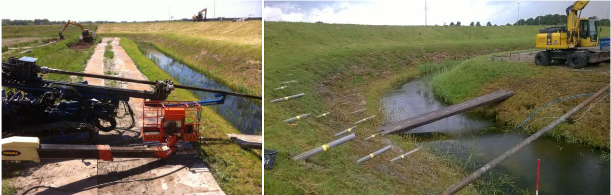
Figuur 12: Foto-impressie van het werkterrein ten behoeve van het aanbrengen van de vernageling.
