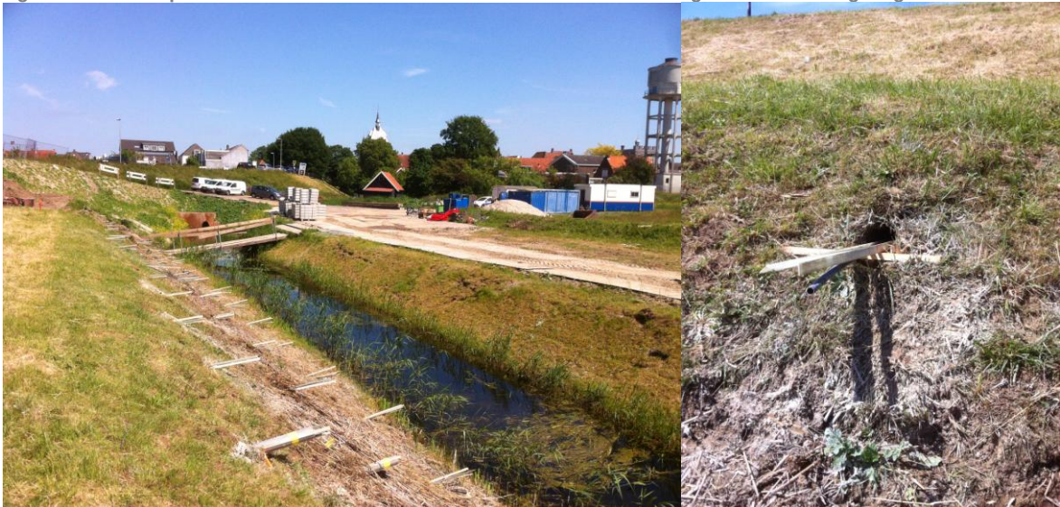
Figuur 13: Foto-impressie van het werkterrein ten behoeve van het aanbrengen van de vernageling.
