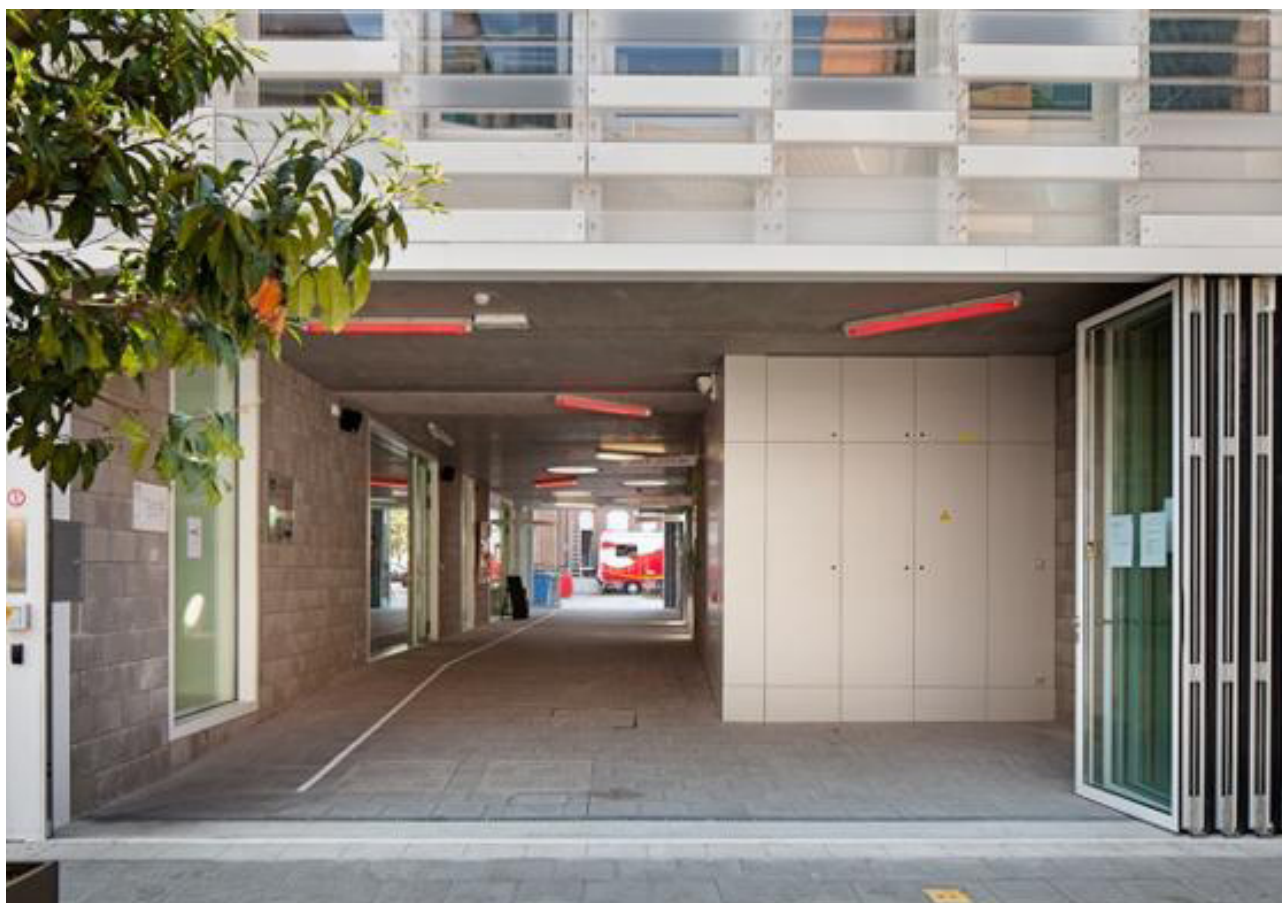
AFBEELDING 4.11 Doorgang naar het jongerencentrum (H30)
