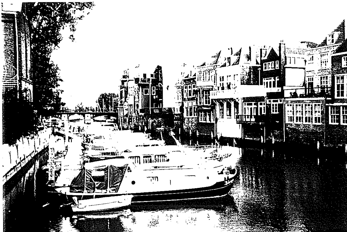
Voorstraatshaven, vanaf Wijnbrug: binnenstedelijk karakter
