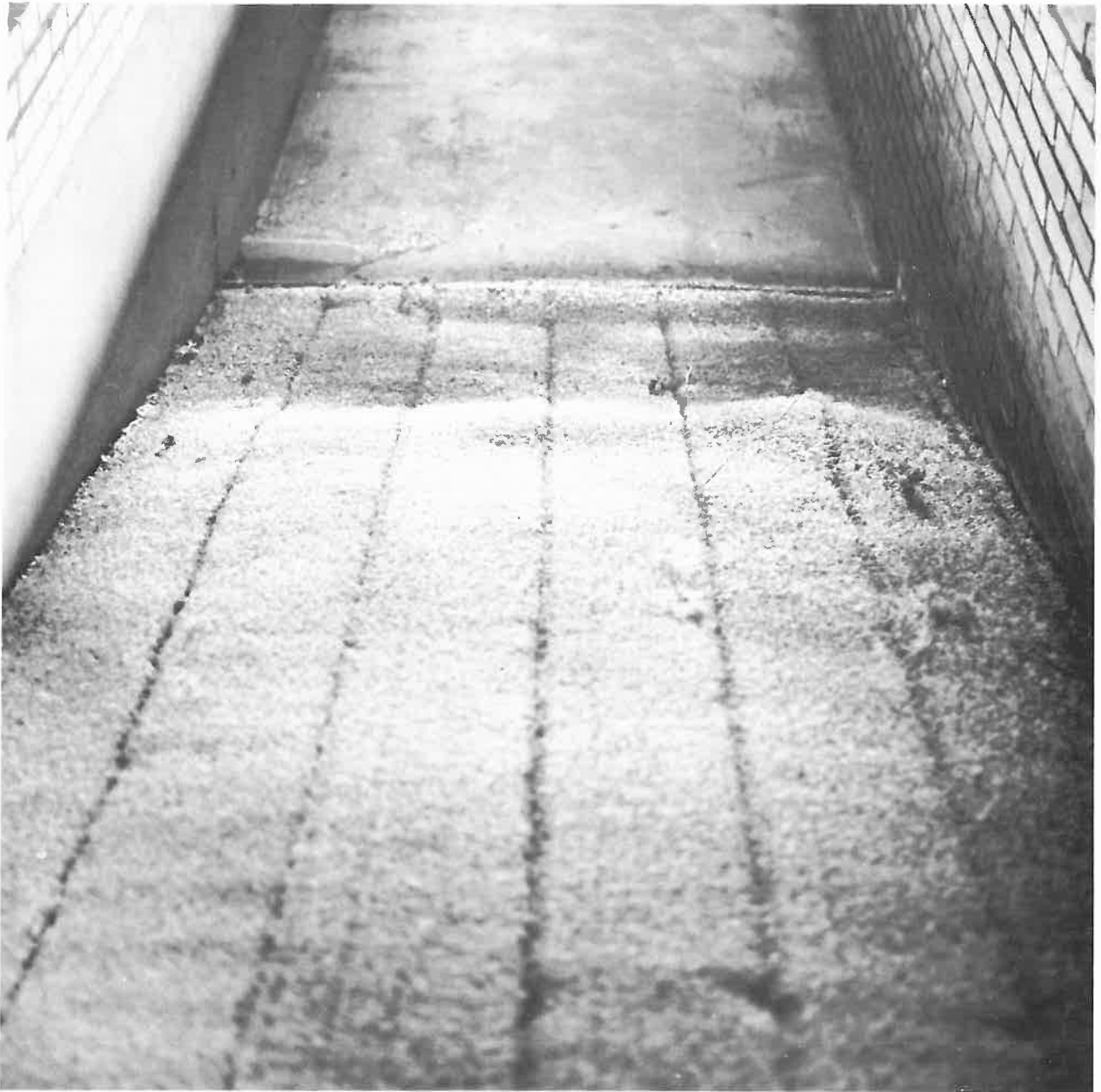
3 T6. Ligging van de Enka-mat na 7 uur golven
