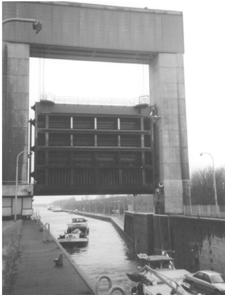
Figure 3.7: Lifting gate Weurt (*Ontwerp van Schutsluizen, 2000*)
