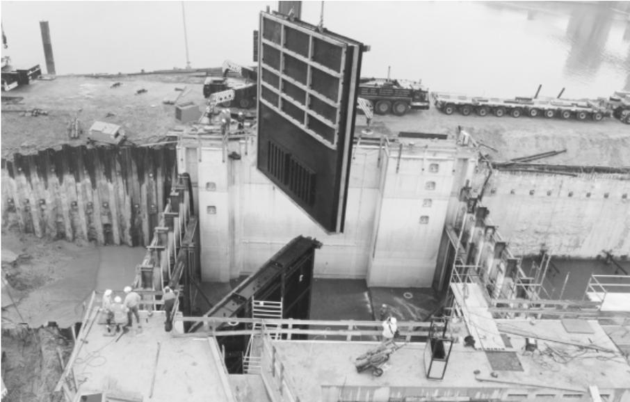
Figure 3.5: Mitre gate Lith (*Ontwerp van Schutsluizen, 2000*)
