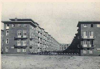
20. Woningbouwveren. Eigen Haard Rivierenlaan. Architect J. Hamers, 1934
