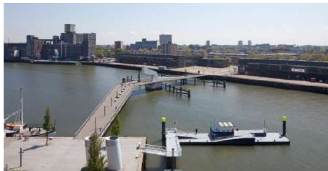
Picture G.3 Rijnhavenbrug
