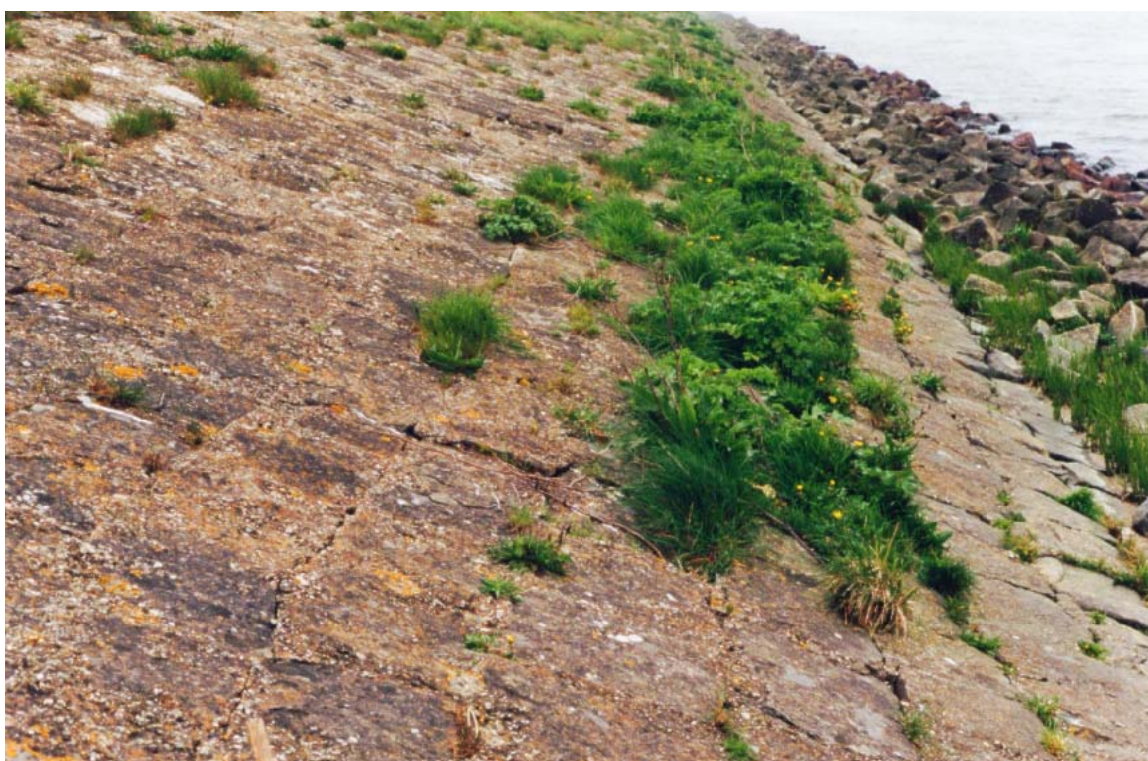
Foto 2.1: Bekleding op het talud van de Wieringermeerdijk plus stortsteenberm
