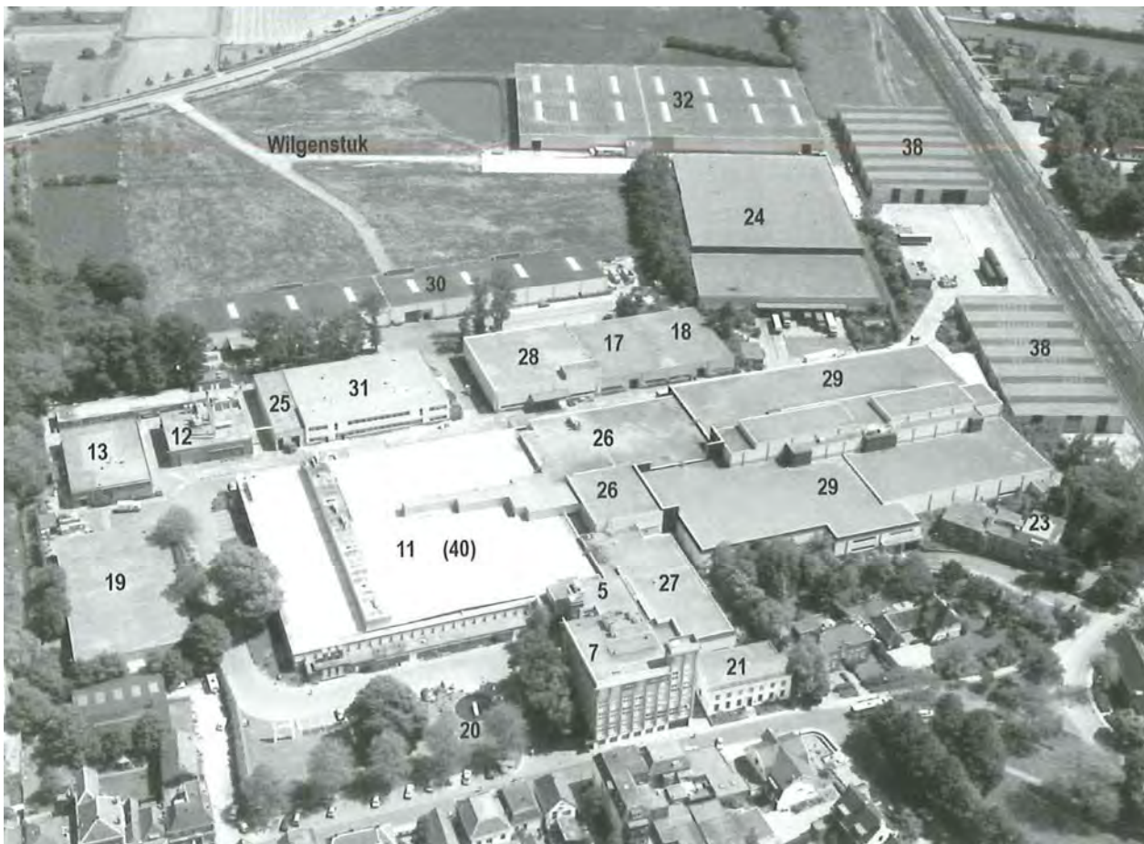
Figuur 56: Op deze luchtfoto uit 1989 staan alle gebouwen die nu nog bestaan, op twee na. Er is vlak na het nemen van deze foto een poortgebouw van de douane neergezet op het Wilgenstuk en tien jaar later nog een droogoven gebouwd tussen 18 en 29. De oudste twee gebouwen op het terrein zijn huis Rijck (21) en de havezate Mathena (23). Naast huis Rijck staan de vooroorlogse fabrieksgebouwen (5 en 7) met daarachter de in 1949 gebouwde fabriekshal (11). Vanaf deze hal is de fabriek langs de binnenstraat naar het zuiden gegroeid, richting de twee NS hallen uit 1980 (38).
