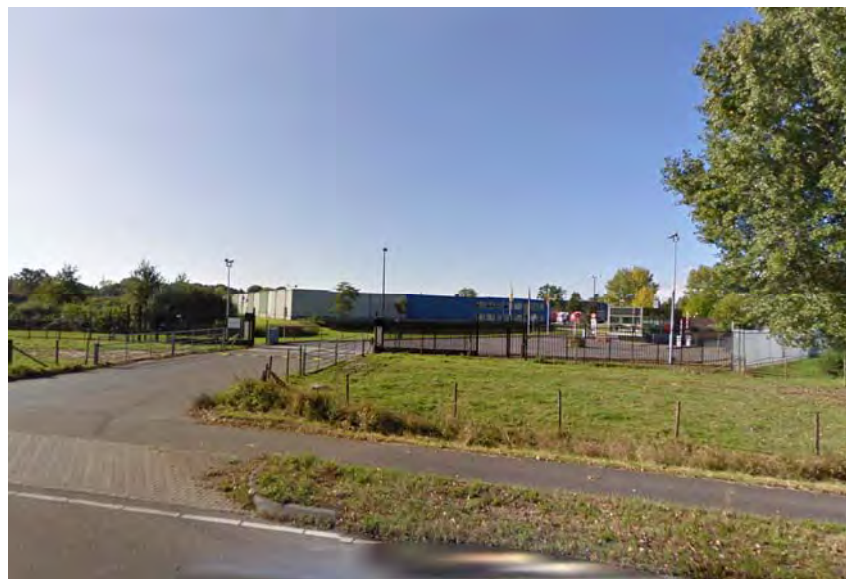
Figuur 72: De ingang van het fabrieksterrein aan de Babberichseweg. Hier ligt de rand van de stad op afstand en half verstopt. De blauw/grijze loods is eind jaren tachtig gebouwd en van lage cultuurhistorische waarde. Wanneer de fabrieksfunctie van het terrein komt te vervallen zou hier een nieuwe ingang voor de stad kunnen komen.
