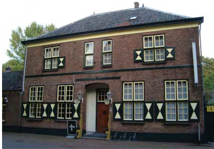
Figuur 20: Voormalig gebouw van de marechaussee aan de Wittenburgstraat.
