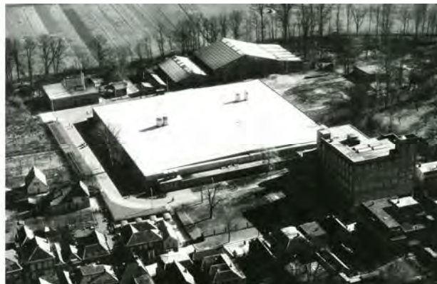
Figuur 53: Luchtfoto uit 1950 van hal. Alle productieprocessen vonden onder één dak plaats. De loodsen en schuren achter de hal zijn de smederij, timmerwerkplaats en het ketelhuis.
