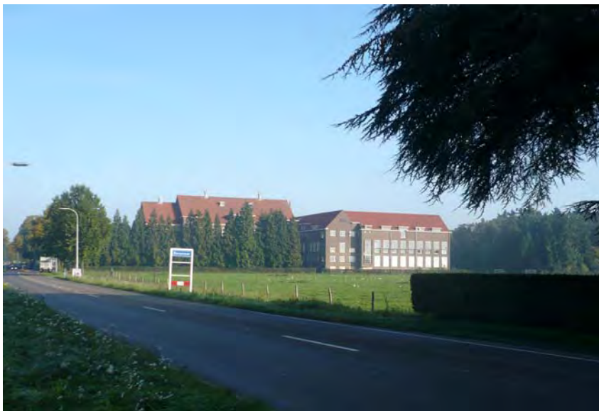
Figuur 71: Aan de noordzijde van het groene hart staat het Juvenaatschool uit 1926. Dit statige gebouw contrasteert sterk met de aangrenzende landerijen en markeert daarmee de entree van Zevenaar aan de zuidoost zijde.
