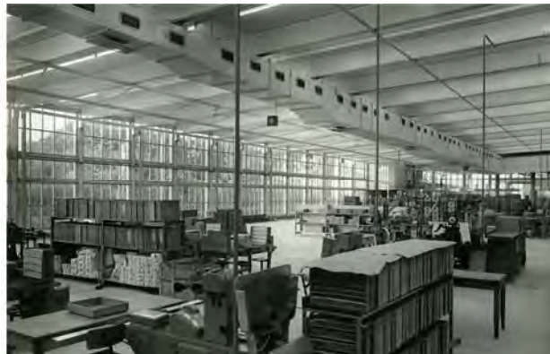
Figuur 51: De grote proporties van de hal (80x85m) hadden tot gevolg dat lang niet iedere werkplek in het daglicht lag. In samenwerking met Philips experimenteerde men hier met TL-verlichting en voor het geval dat niet afdoende zou zijn, was het dak zo opgebouwd dat er gemakkelijk stroken uit genomen kon worden om daklichten te kunnen plaatsen.
