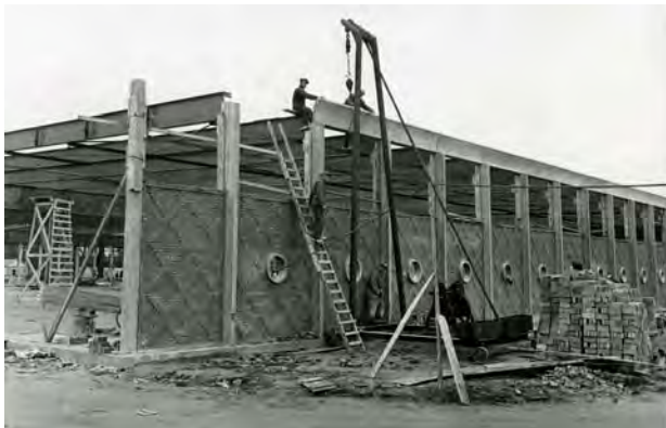
Figuur 50: Na de oorlog wordt er, op de plek waar Enghuizen heeft gestaan, een nieuwe fabriekshal gebouwd. Deze nieuwe hal heeft een skelet van tweedehands staal, afkomstig van een brug die nooit gebouwd werd, en de gevel bestaat uit prefab-betonnen elementen en ambachtelijk metselwerk.
