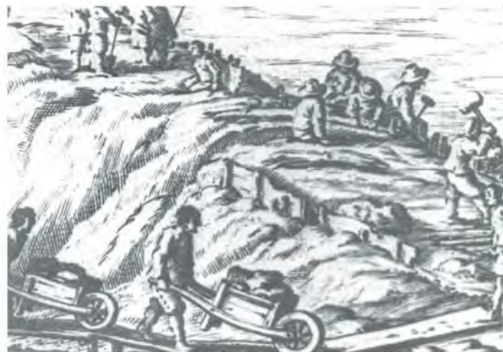
Figuur 11: Dijk aanleg met eenvoudige hulpmiddelen is een onvoorstelbaar omvangrijke klus, die naast vakmanschap vooral ook veel logistiek inzicht vraagt.
