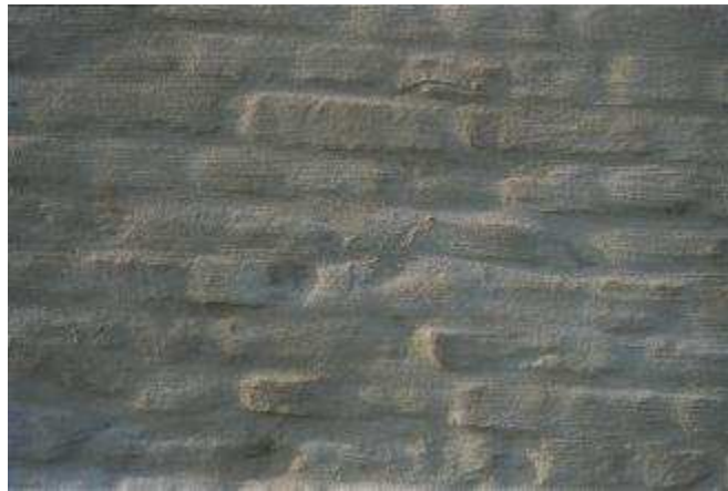
Fig. 7. Abdij, Aerschot, België: vertinlaag (Naldini 2001).
