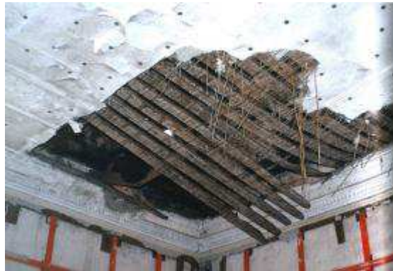
Fig. 29. Kasteel, Zwijnsbergen, Helvoirt: Zichtbare ondersteuning voor een gestuct plafond (hout en riet) (Uit: Geerken & Freling 2010).
