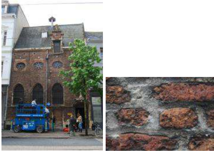
Fig. 22. Schoemakerskapel in Antwerpen, België, tijdens de inspectie.
