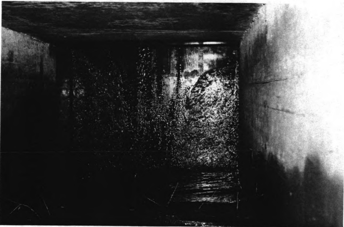
Figuur 26: Lekkage binnenschuif
