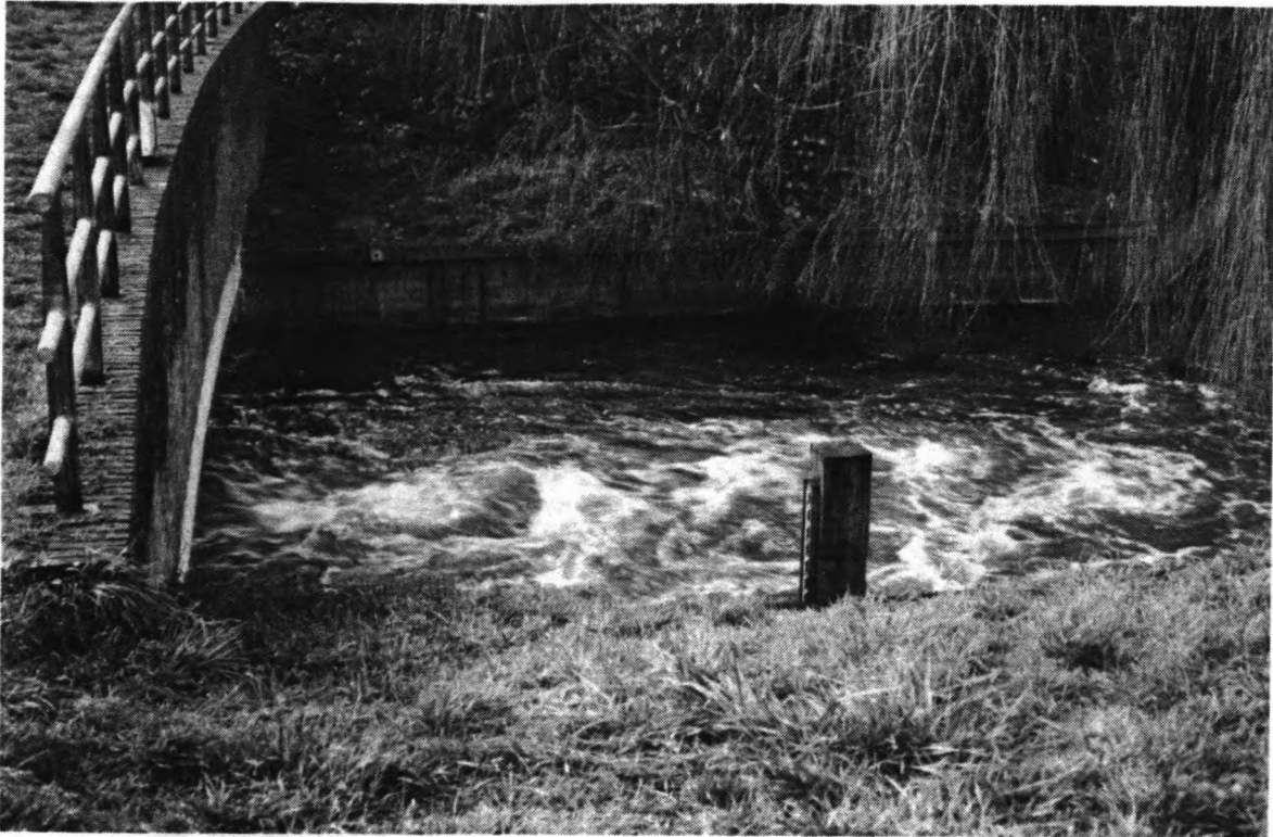
Figuur 28: Turbulentie in de uitstroom bij het grootste debiet
