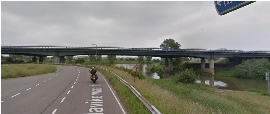
Figuur 2-5 de Middachterbrug, de A348 kruist hier een zijtak van de IJssel. Dit een liggerbrug met een overspanning van 79 meter.
