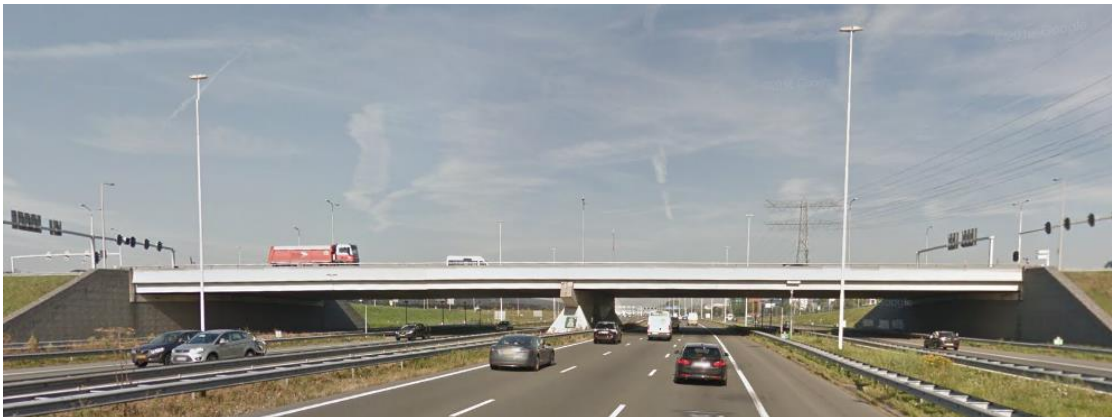
Figuur 2-1 het Lageweideviaduct over de A2 bij Utrecht met een totale lengte van ongeveer 94 meter en twee overspanningen van 47 meter.
