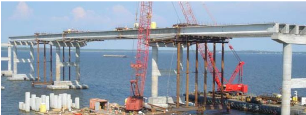
Figuur 5-4 een Spliced girder bridge tijdens de bouw.
