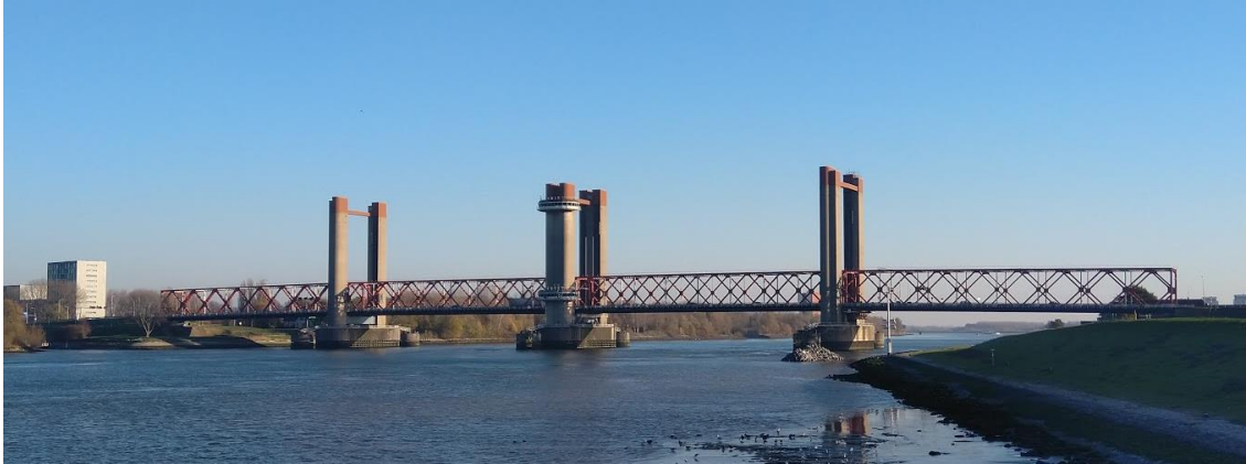
Figuur 2-4 de Spijkenisserbrug, met een overspanning van 100 meter, met hergebruikte overspanningen van de Moerdijkbrug.
