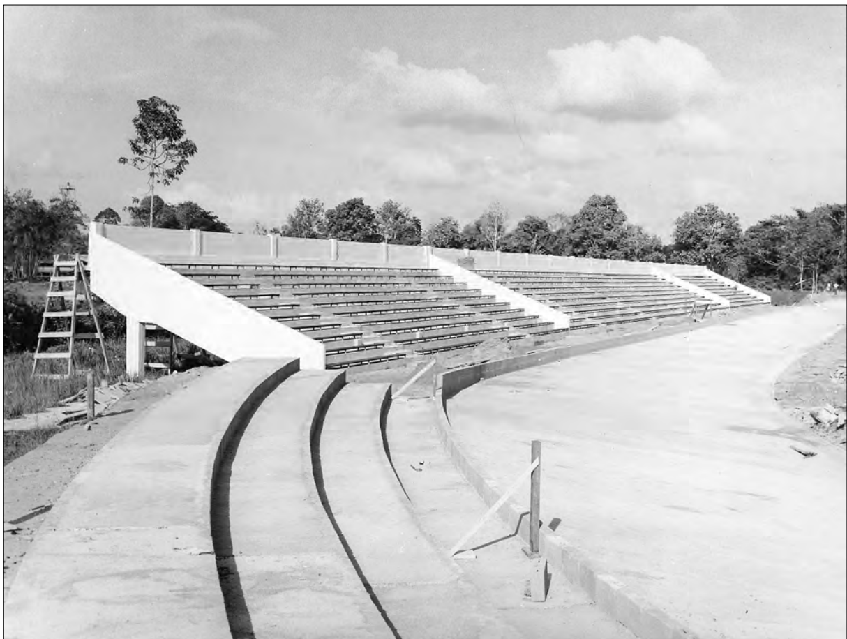
De open tribune in aanbouw
