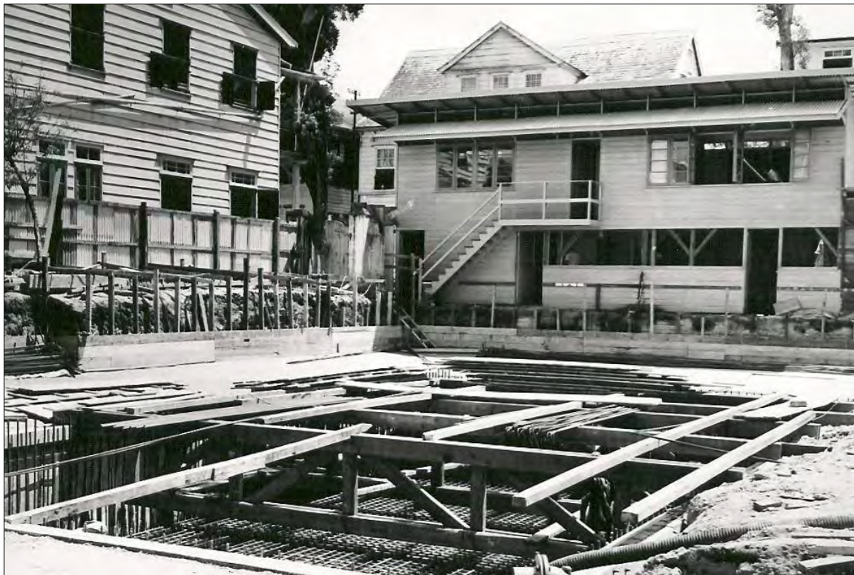
De betonwapening voor de keldervloer en de wanden
