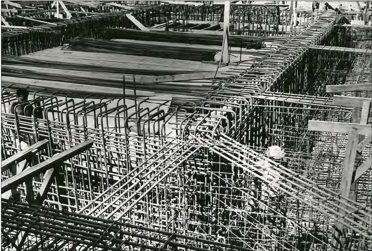
Het betonijzer ligt gereed voor de ijzervlechters
