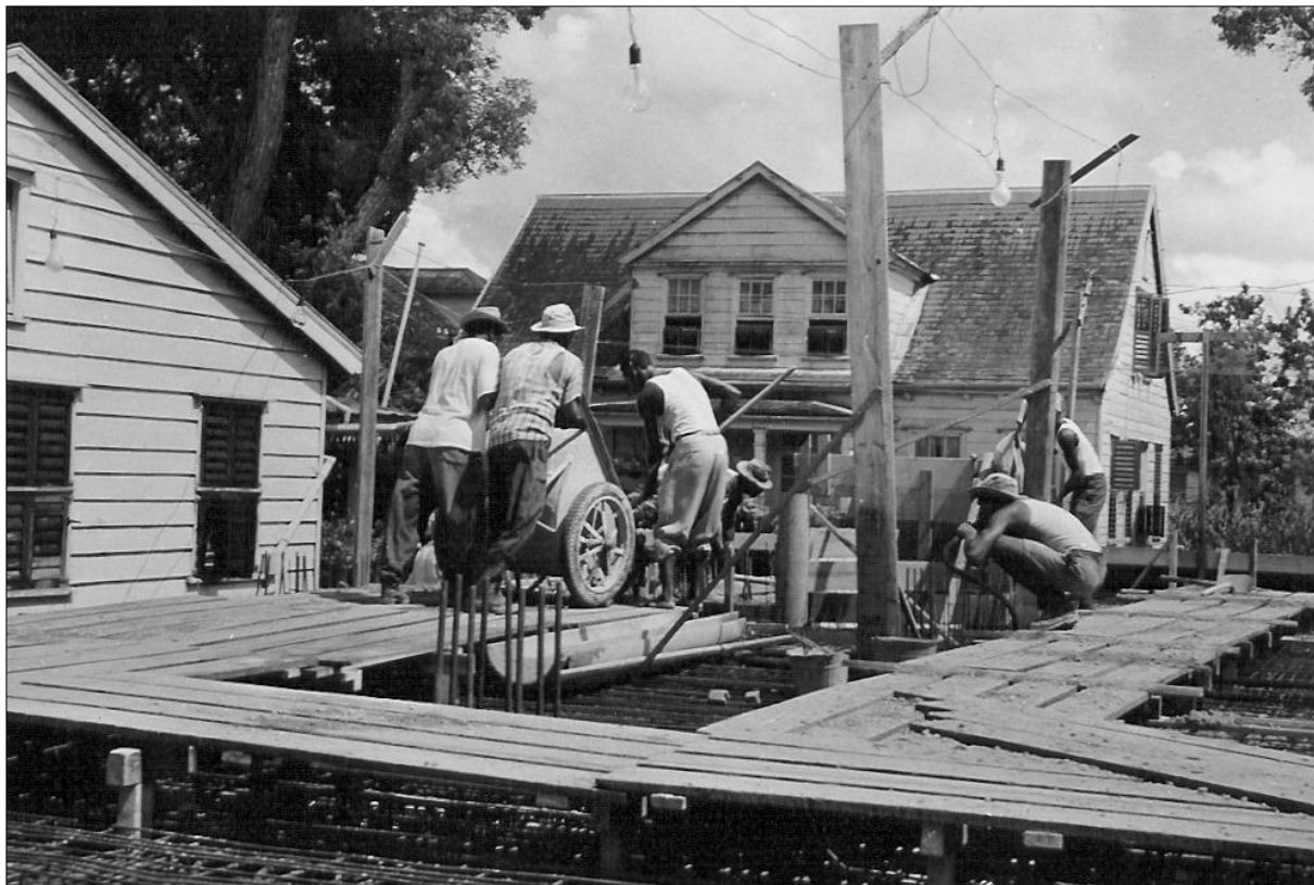
Betonstorten op de 1 e verdieping
