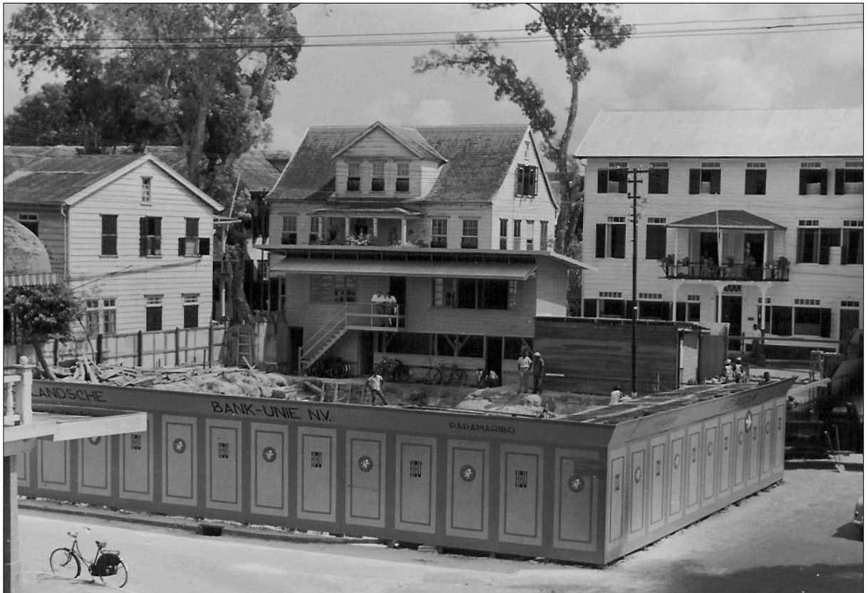
De schutting om het bouwterrein is geplaatst
