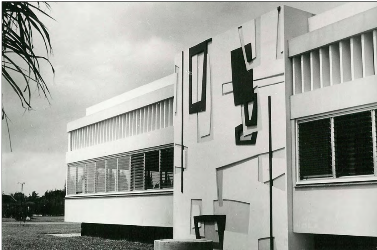
Het gebouw, met de kleurrijke vlakversiering in reliëf aangebracht, is gereed
