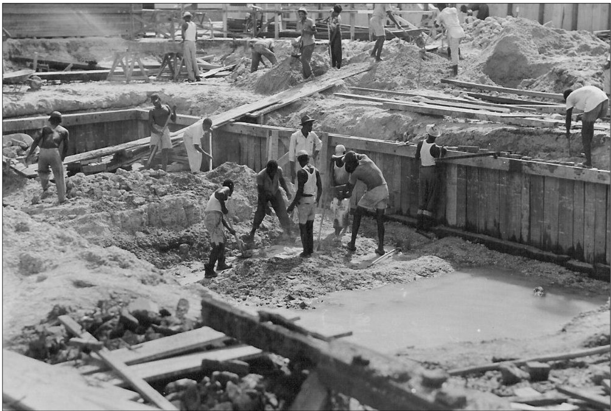
Het plaatsen van damwanden en uitgraven van de fundering
