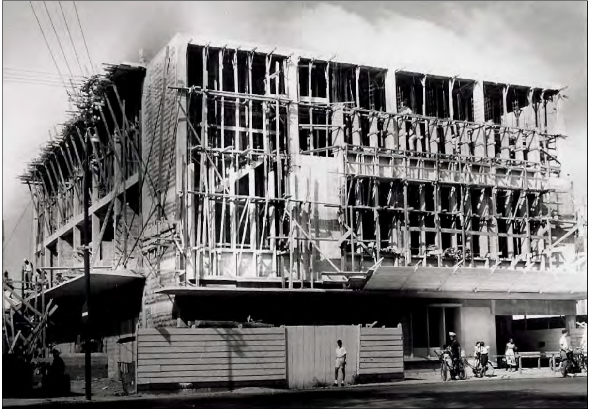
De linkerzijgevel en de achtergevel
