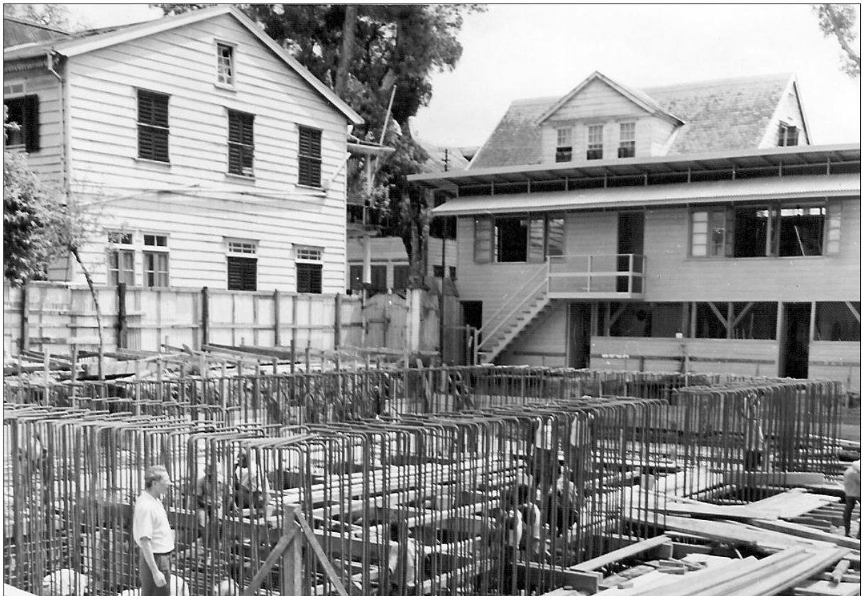
De betonwapening voor de begane grond
