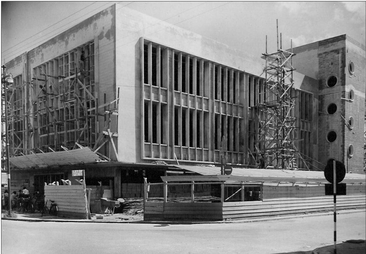
De linkervleugel komt uit de steigers
