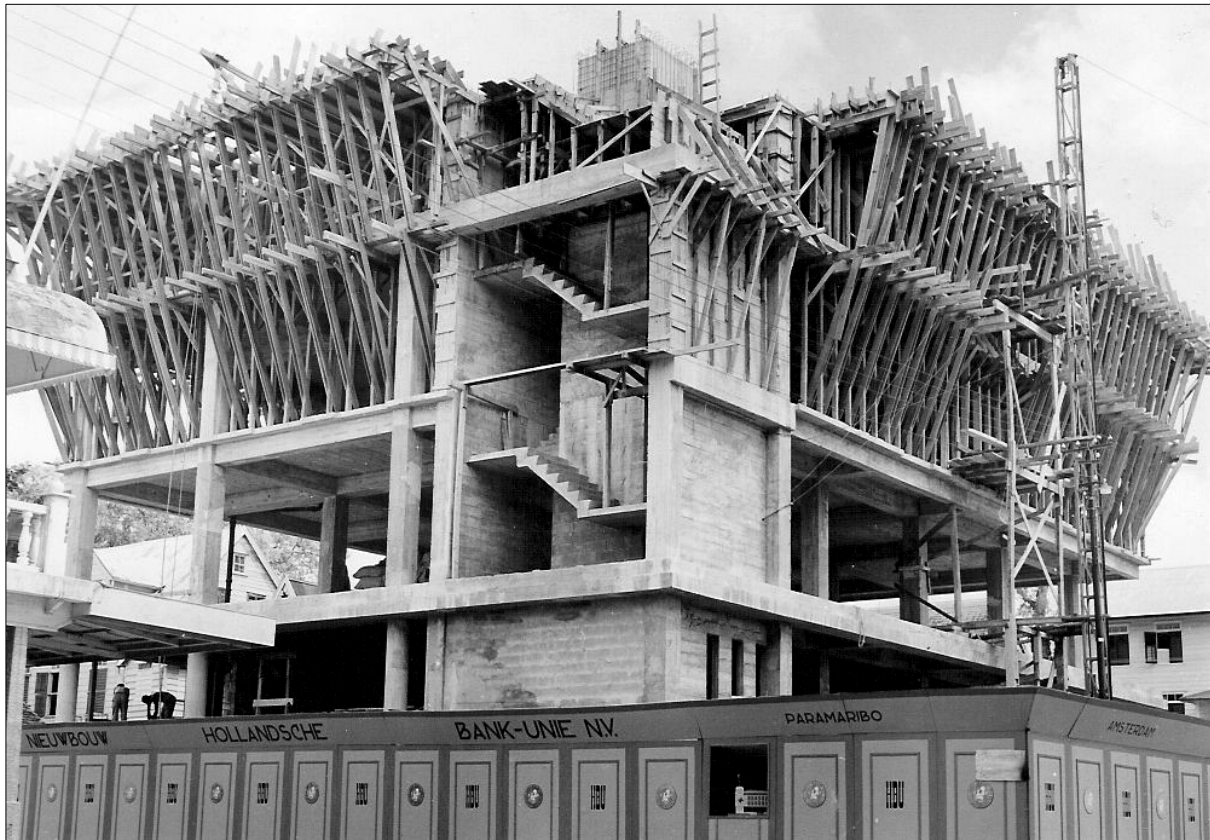
De 3 e verdieping en het dak in de bekisting
