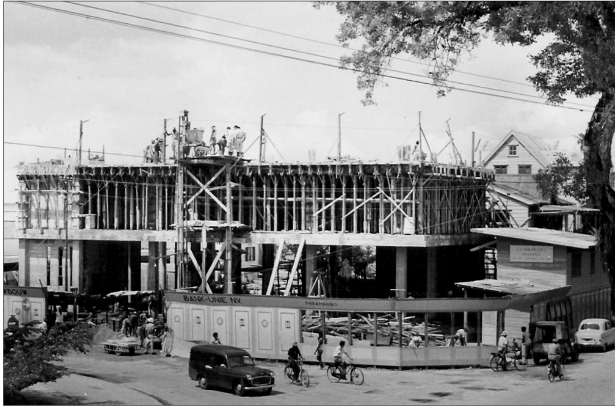
Betonstorten op de 2 e verdieping
