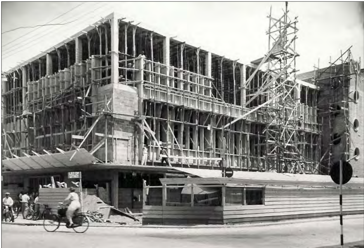
De linkervleugel en de toren in aanbouw
