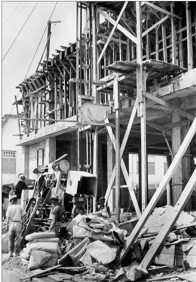
Betonstorten op de 2 e verdieping
