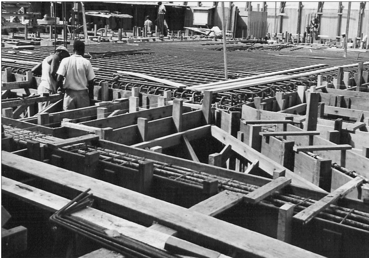
Het aanbrengen van de bekisting
