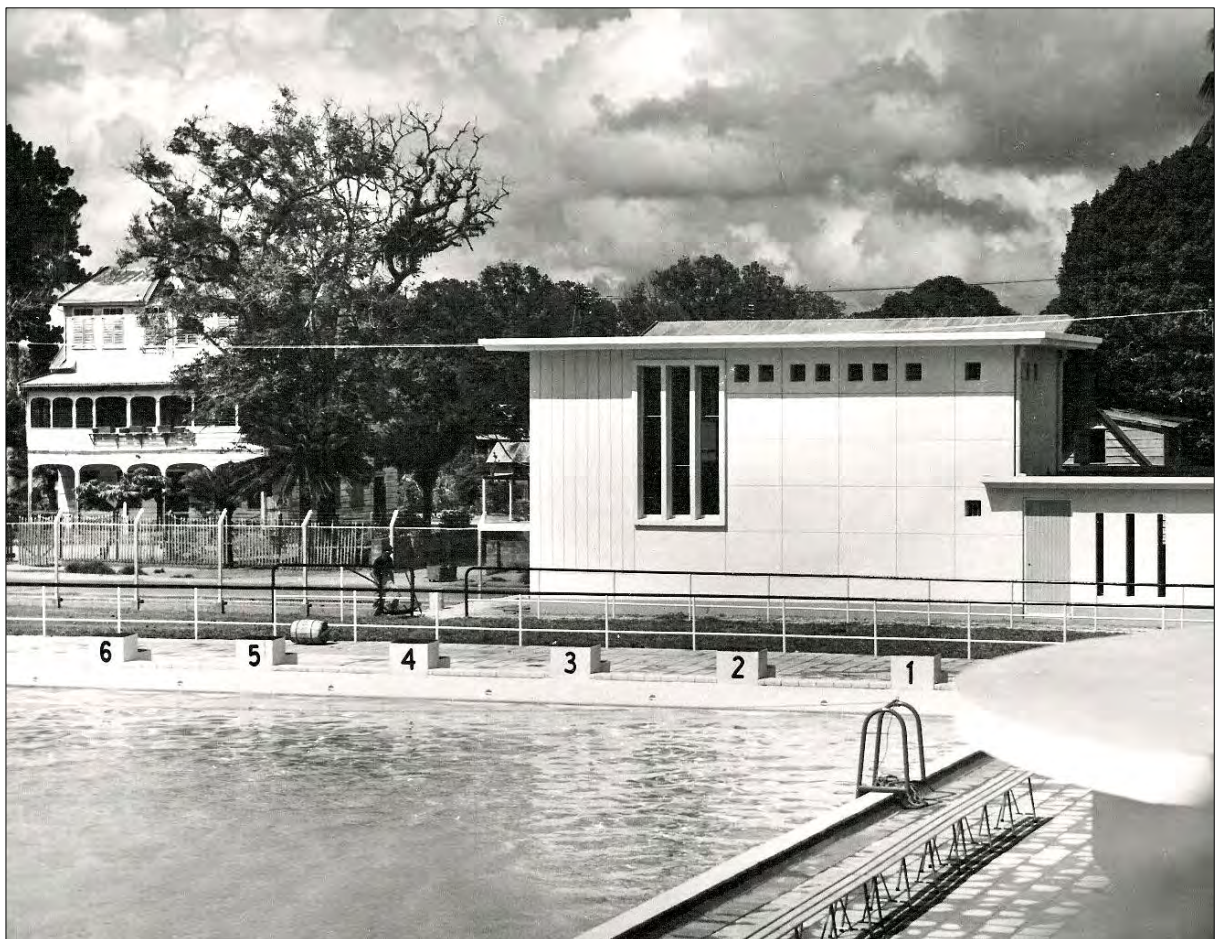
De 6 startblokken en het pompgebouw
