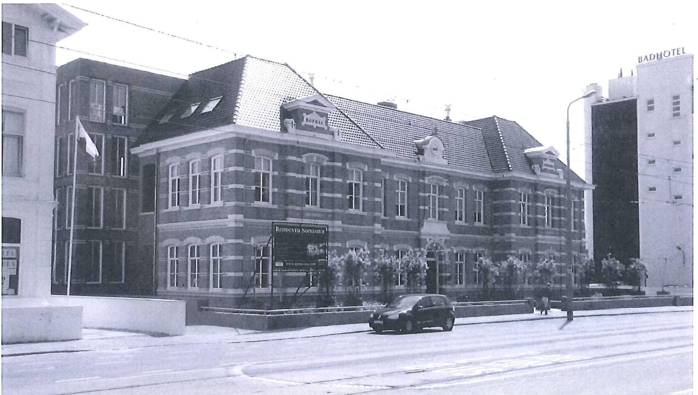
Gebouwtransformatie: verpleeggebouw werd woonresidentie in Scheveningen.
