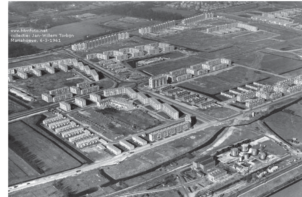
> figuur 3.4 Vogelvlucht van Mariahoeve in aanbouw (1961)
