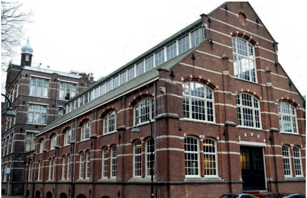
Het Techniek Museum Delft TMD was gevestigd in vroegere laboratoriumhallen van de Faculteit der Werktuigbouwkunde en Scheepsbouwkunde, met adres Ezelsveldlaan, Delft. Hier: Laboratorium Hal 1.
