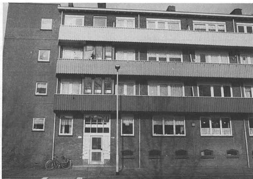
Afbeelding 4.2: De balkonhekken die in 1974 zijn aangebracht bij complex 012, foto 1987.
