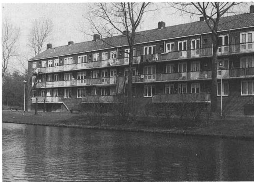
Afbeelding 3.5: Komplex 013, achtergevel van bouwblok aan de Voorweg, 1987.
