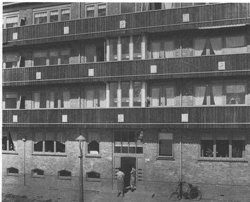
Afbeelding 4.1: De oorspronkelijke balkonhekken van complex 012. Foto: Gemeente Rotterdam Fotografie, afd. D.G.G., circa 1954.
