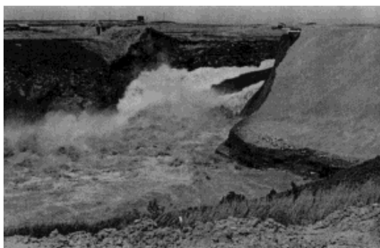
Teton Dam Faaltraject van primaire microinstabiliteit tot een doorbraak in het plaatje rechtsonder
