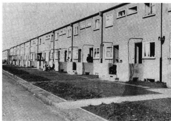
Straatbeeld, derde bouwphase 1928-29
