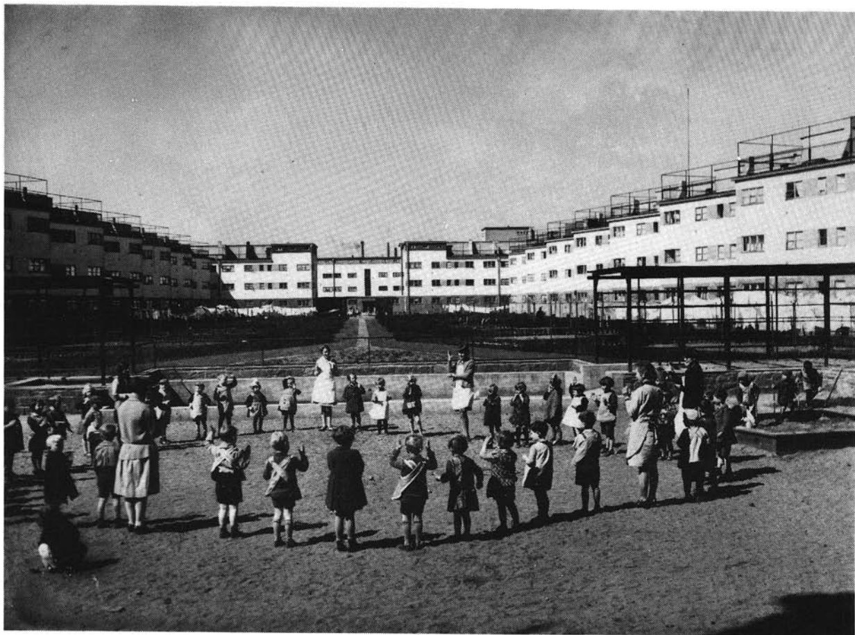
Crèche, woonwijk Bruchfeldstrasse
