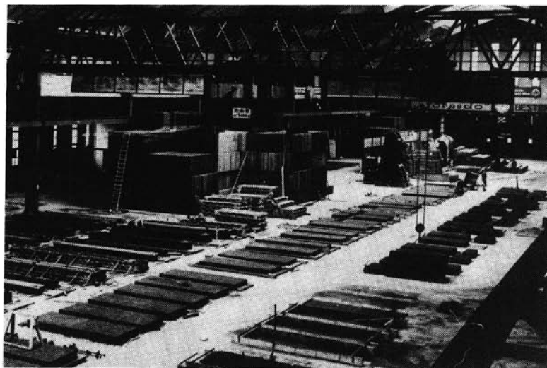
Productiehal van de Frankfurtse montage- bouw in het Huis van de Techniek op het terrein van de Frankfurter Messe, 1927
