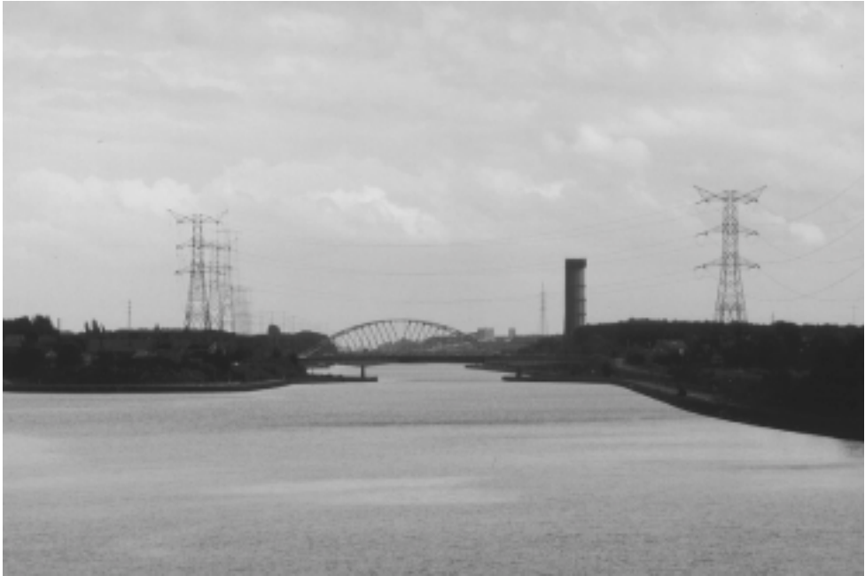
Foto 4.3: Interne wisseling in een bundeling van het Albertkanaal en een hoogspanningslijn te Herentals (B)
