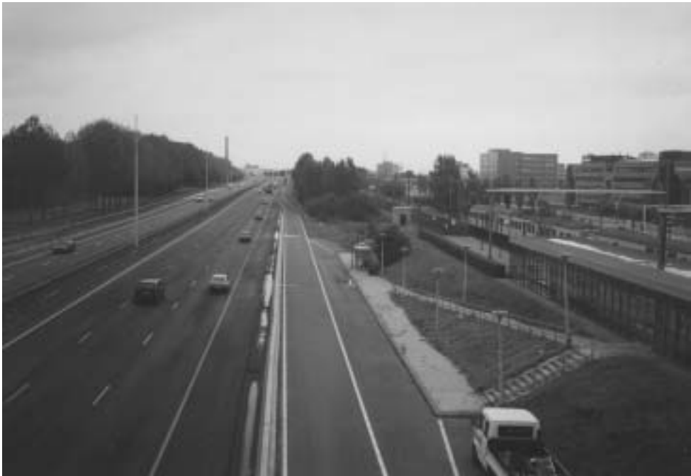
Foto x: Nevenschikte strakke bundeling met functionele tussenruimte op gelijk niveau bij de A12 en de spoorlijn Den Haag-Utrecht
