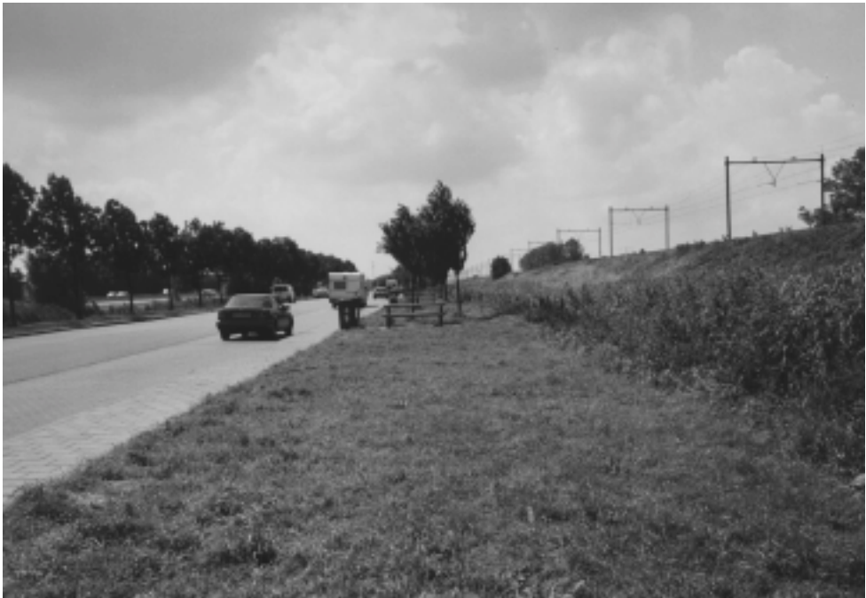
Foto xv: Nevenschikte strakke bundeling op ongelijk niveau met functionele tussenruimte
