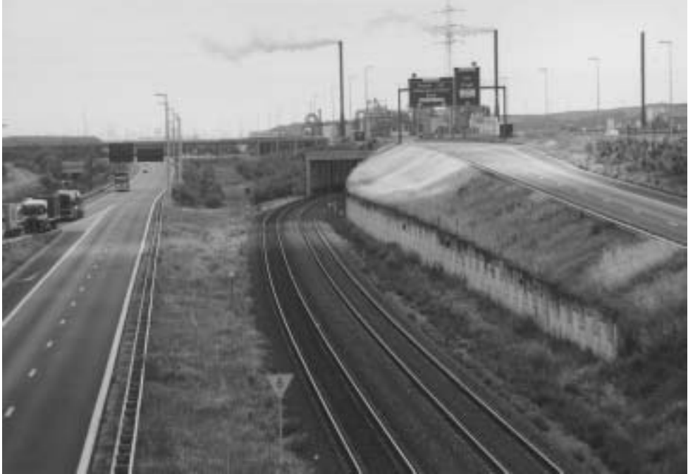
Foto 5.4: Noodzakelijke overbrugging van de autosnelweg bij het verlaten van de bundeling door de havenspoorlijn ter hoogte van Stabroek (B)
