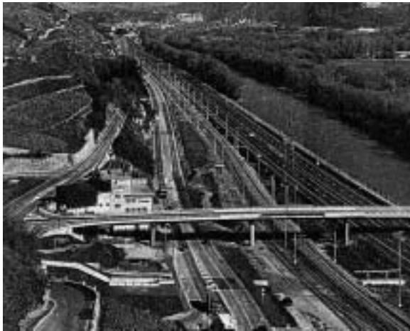
Foto vi: Situatie na aanleg N9
