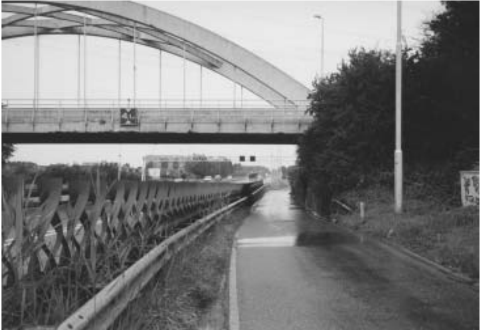
Foto 5.3: Scheidingsconstructie ter voorkoming van verblinding op gebundelde infrastructuurlijnen (A15 en lokale weg ter hoogte van Giessendam)
