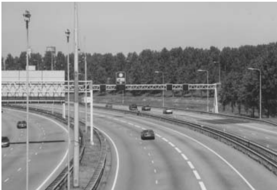
Foto 2.1: Functionele scheiding en ruimtelijke bundeling op de autosnelweg A16 ter hoogte van de Van Brienenoordbrug te Rotterdam
