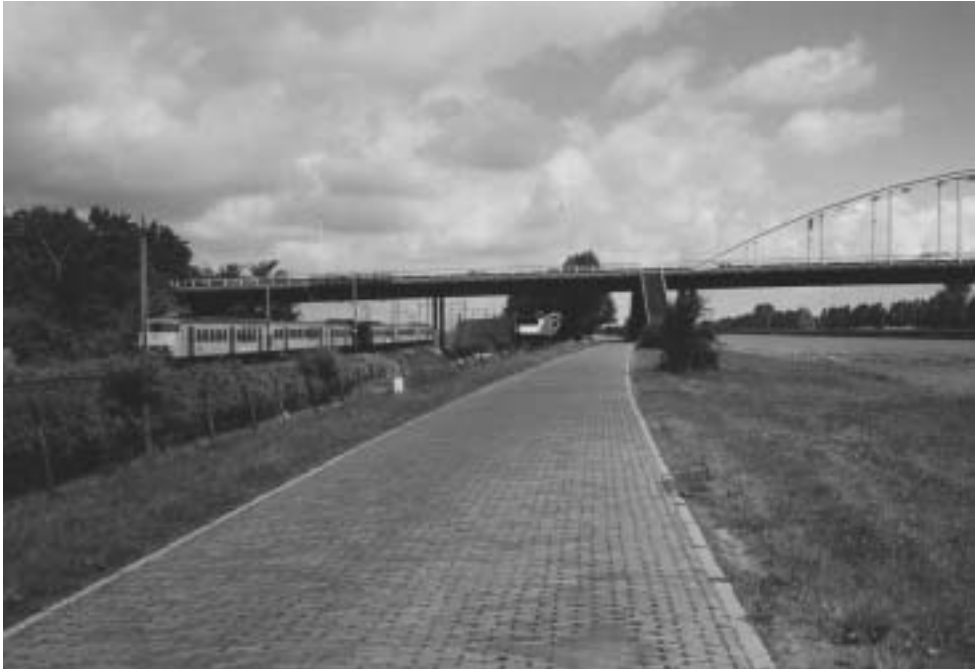
Foto 5.2: Gezamenlijk overbrugging van de spoorlijn Amsterdam-Utrecht, een lokale weg en het Amsterdam-Rijnkanaal
