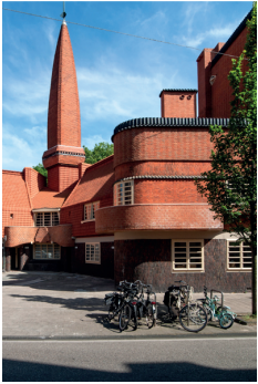
Renovation Het Schip, Archivolt architecten
