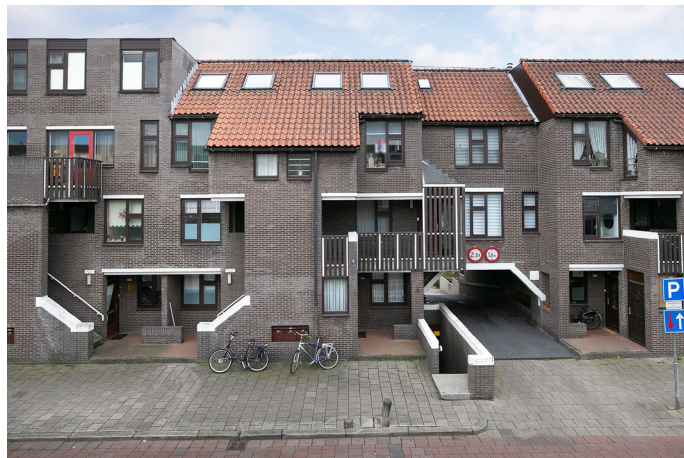
Rotterdamsdijk, Schiedam (Funda, 2022)
