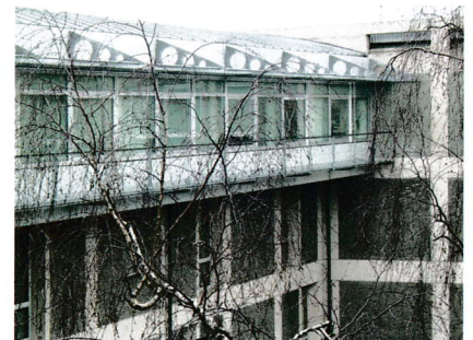
De uitbreiding van de zuidelijke vleugel die aan beide zijden 1,85 meter over de bestaande verdieping uitkraagt | Foto H. Zijlstra
