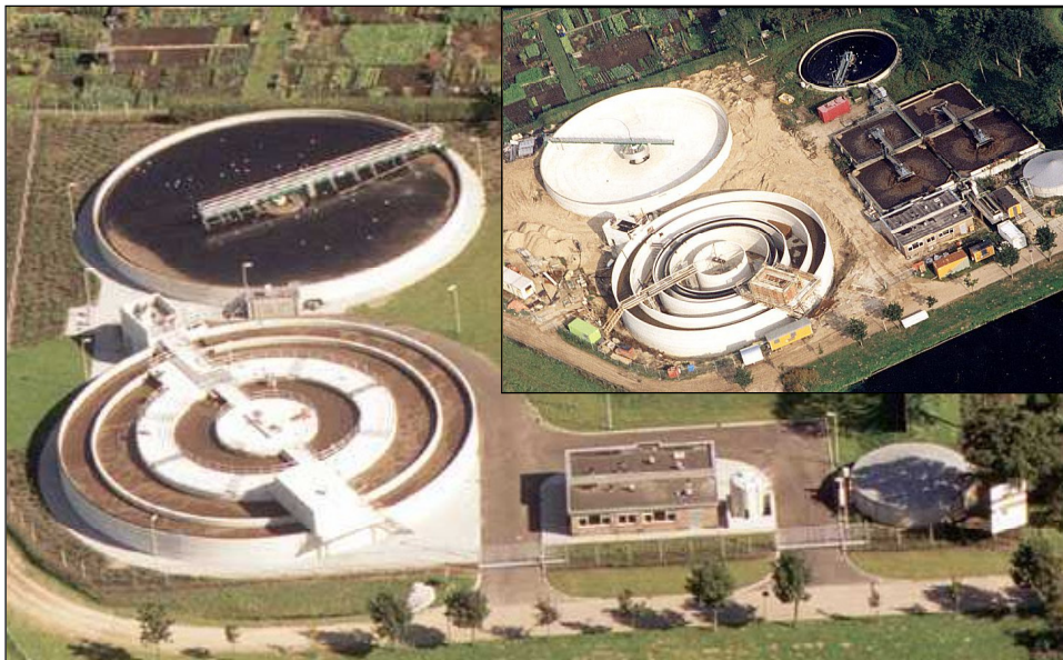
Figuur 0.1 Luchtfoto van de rioolwaterzuiveringsinstallatie Ommen. In de ronde, in compartimenten verdeelde reactoren wordt het rioolwater gezuiverd. De bacteriën worden van het water gescheiden in de nabezinker. In de inzet: rwzi Ommen in aanbouw met daarnaast het oude zuiveringsproces.
