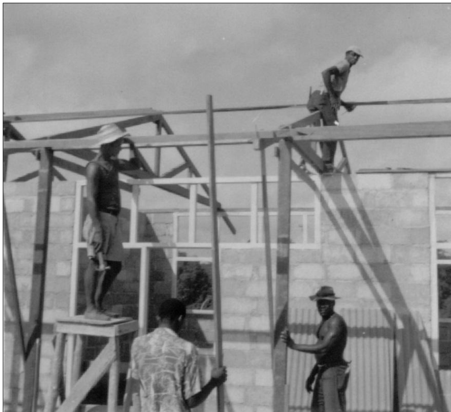
De dakspanten worden gemonteerd
