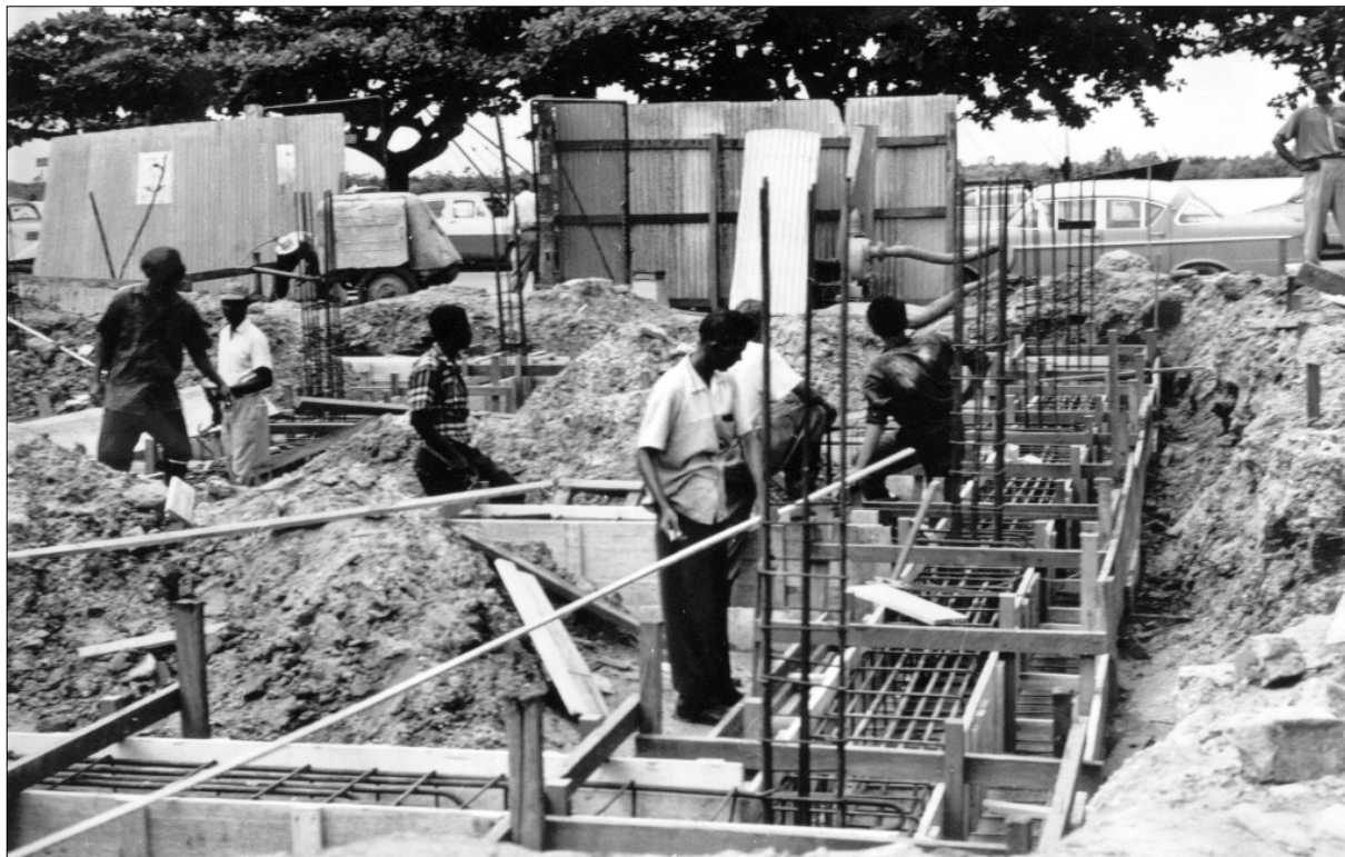
De fundering van de uitbreiding
