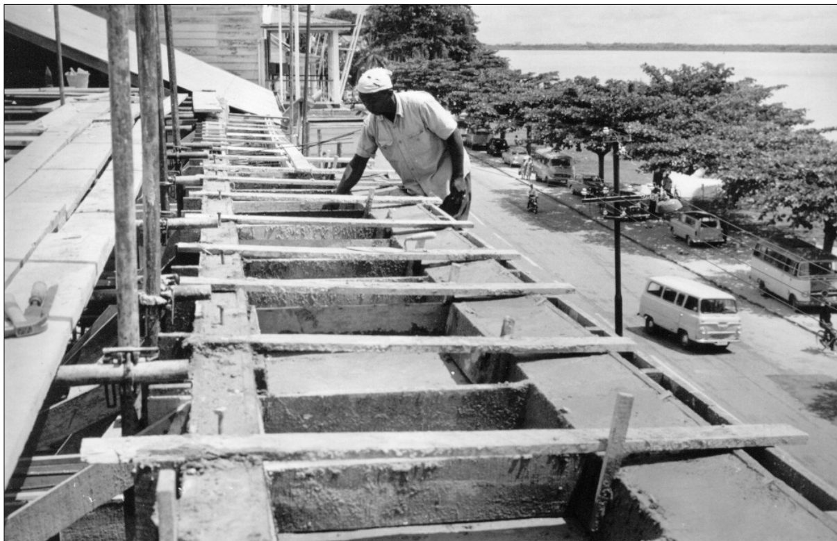
Het betonstorten is klaar
