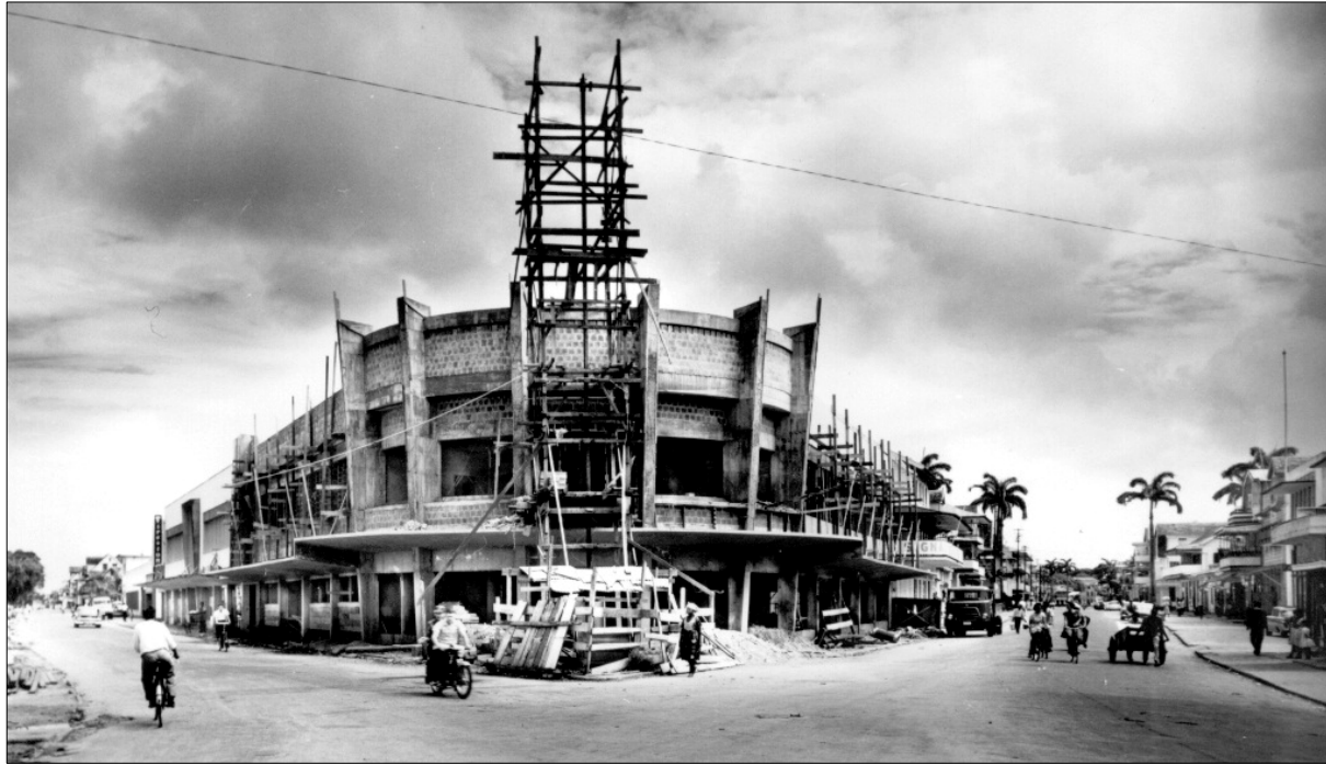
Voortgang van de bouw
