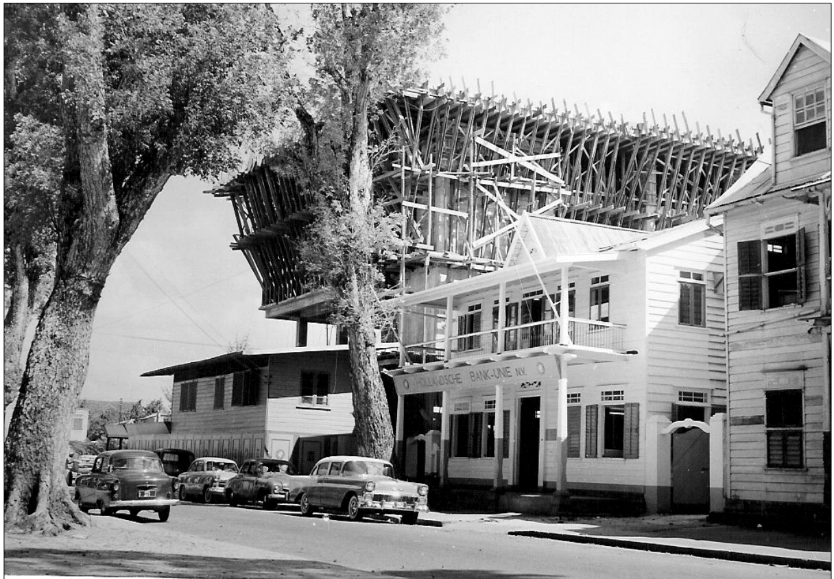
Een imposante draagconstructie t.b.v. het overstekende dak
