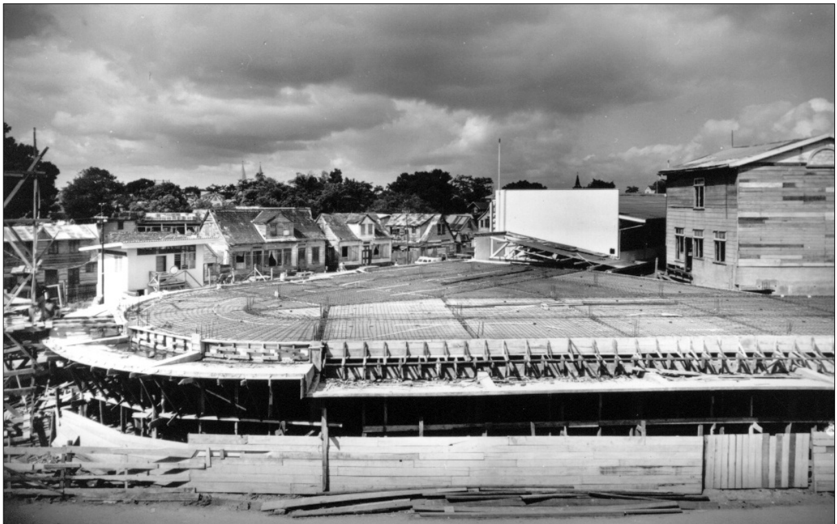
Bekisting en bewapening voor de eerste verdieping
