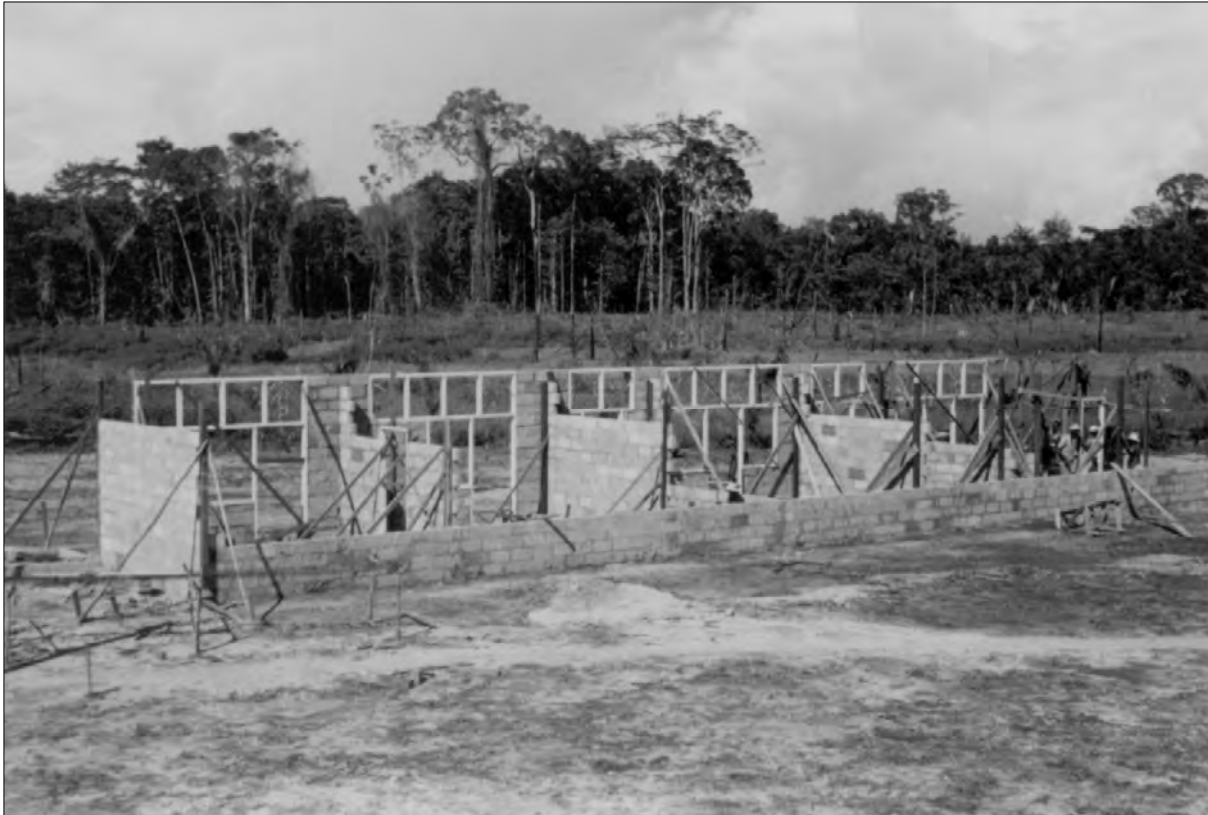
Beginstadium van het ziekenhuis met de reeds geplaatste kozijnen
