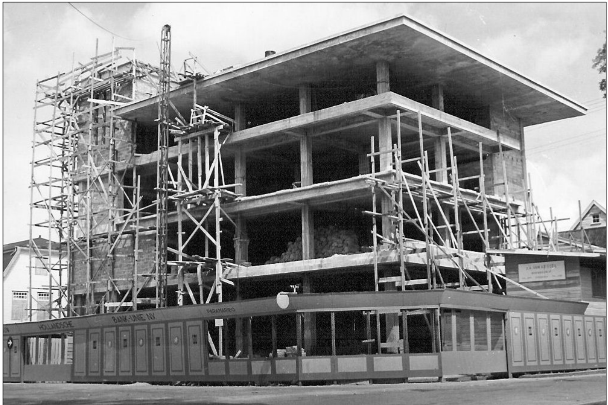
Het gebouw begint vorm te krijgen
