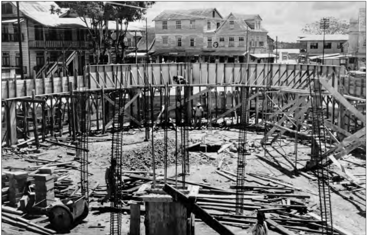
Na de sloop de eerste fase van de bouw
